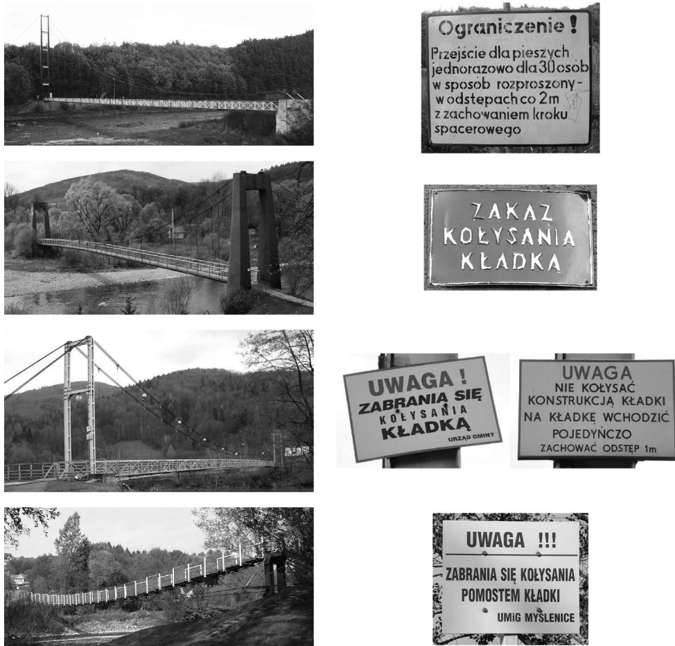
Il. 1. Przykłady ograniczeń ruchu pieszych i zakazów wzbudzania drgań na kładkach dla pieszych jako efekt dużej podatności dynamicznej konstrukcji (od góry: kładka dla pieszych w Piwnicznej-Zdroju, kładka dla pieszych w Suchej Beskidzkiej, kładka dla pieszych w Czernichowie w pobliżu zapory wodnej Tresna, kładka dla pieszych w Myślenicach)
