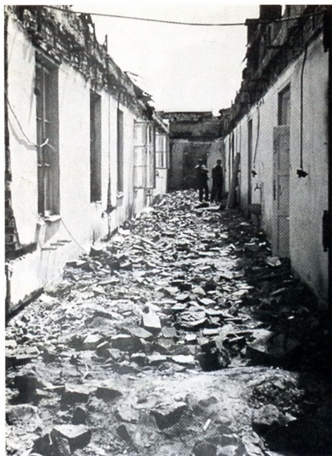
7. Korytarz w spalonym skrzydle na drugim piętrze gmachu głównego Akademii Górniczej – kwiecień 1945
