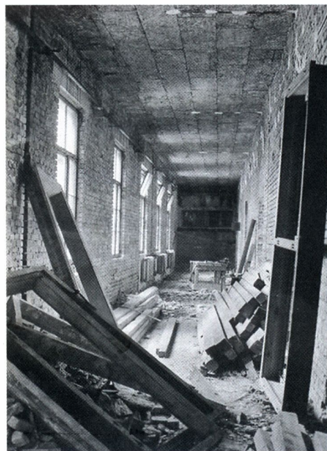
8. Prace remontowe na korytarzu trzeciego piętra gmachu głównego Akademii Górniczej – lipiec 1947
