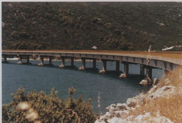
Zespolony most belkowy nad zatoką Kanalu Malog Stona w Chorwacji
