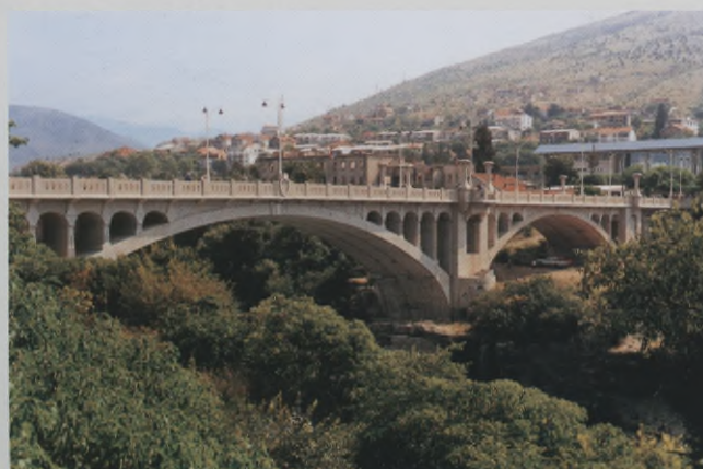
Łukowy most betonowy na Neretwie w Mostarze
