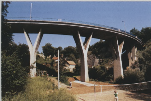
Żelbetowy most płytowy na Koranie w Slunj
