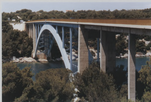
Stalowy most łukowy nad Šibenskim Kanalem w Brodarici
