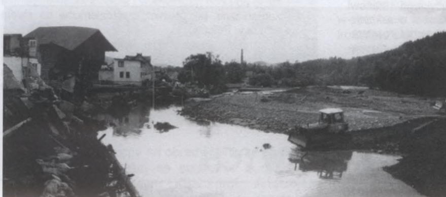
Rz. Soła, m. Rajcza – 11.07.1977 r. Zerwany prawy brzeg, zniszczona ulica i domy mieszkalne
