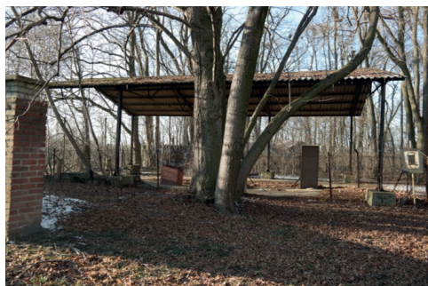
Il. 8. Stacja paliw z zachowanymi dystrybutorami MERA-ZAP z lat 70. w Pszczeliej Woli, 2022. Fot. M. Wdowiarz-Bilska
