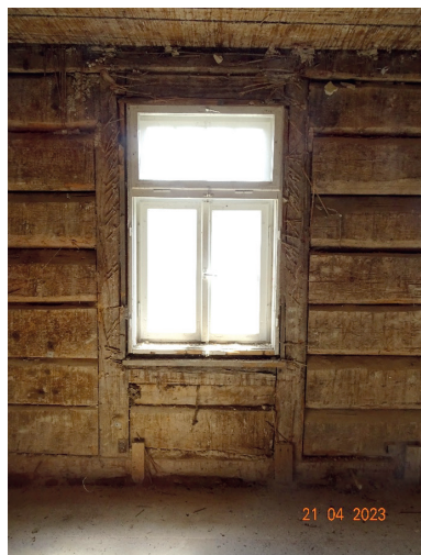
Il. 9. Konstrukcja drewniana we wnętrzu Gasthof Goldene Aussicht. Fot. D. Przygodzki
