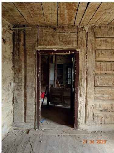
Il. 10. Konstrukcja drewniana we wnętrzu Gasthof Goldene Aussicht. Fot. D. Przygodzki
