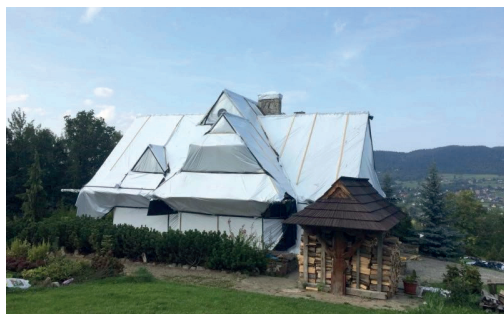
Il. 14. Widok na przykładowy obiekt drewniany przygotowany do przeprowadzenia zabiegu fumigacji fosforowodorowej. Źródło: https://www.korniki-drewno.pl/fumigacja-domu-gazowanie/ (dostęp: 26.06.2024)
