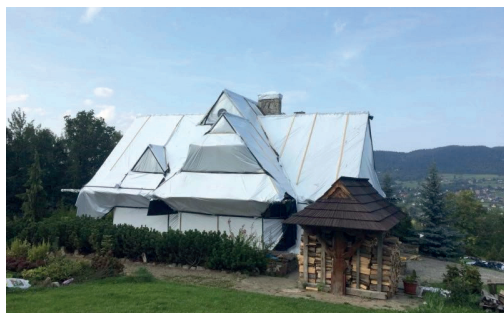
Il. 14. Widok na przykładowy obiekt drewniany przygotowany do przeprowadzenia zabiegu fumigacji fosforowodorowej. Źródło: https://www.korniki-drewno.pl/fumigacja-domu-gazowanie/ (dostęp: 26.06.2024)
