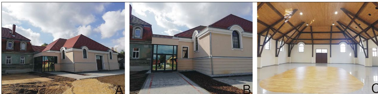
Ryc. 4. Budynek dawnej ujeżdżalni koni zespołu folwarcznego w Kochcicach – obecnie sala wielofunkcyjna usługowa (stan z 2023): A – widok od strony północnej, od dziedzińca wewnętrznego zabudowy; B – widok wejścia głównego; C – widok wnętrza budynku; fot. M. Brus.
