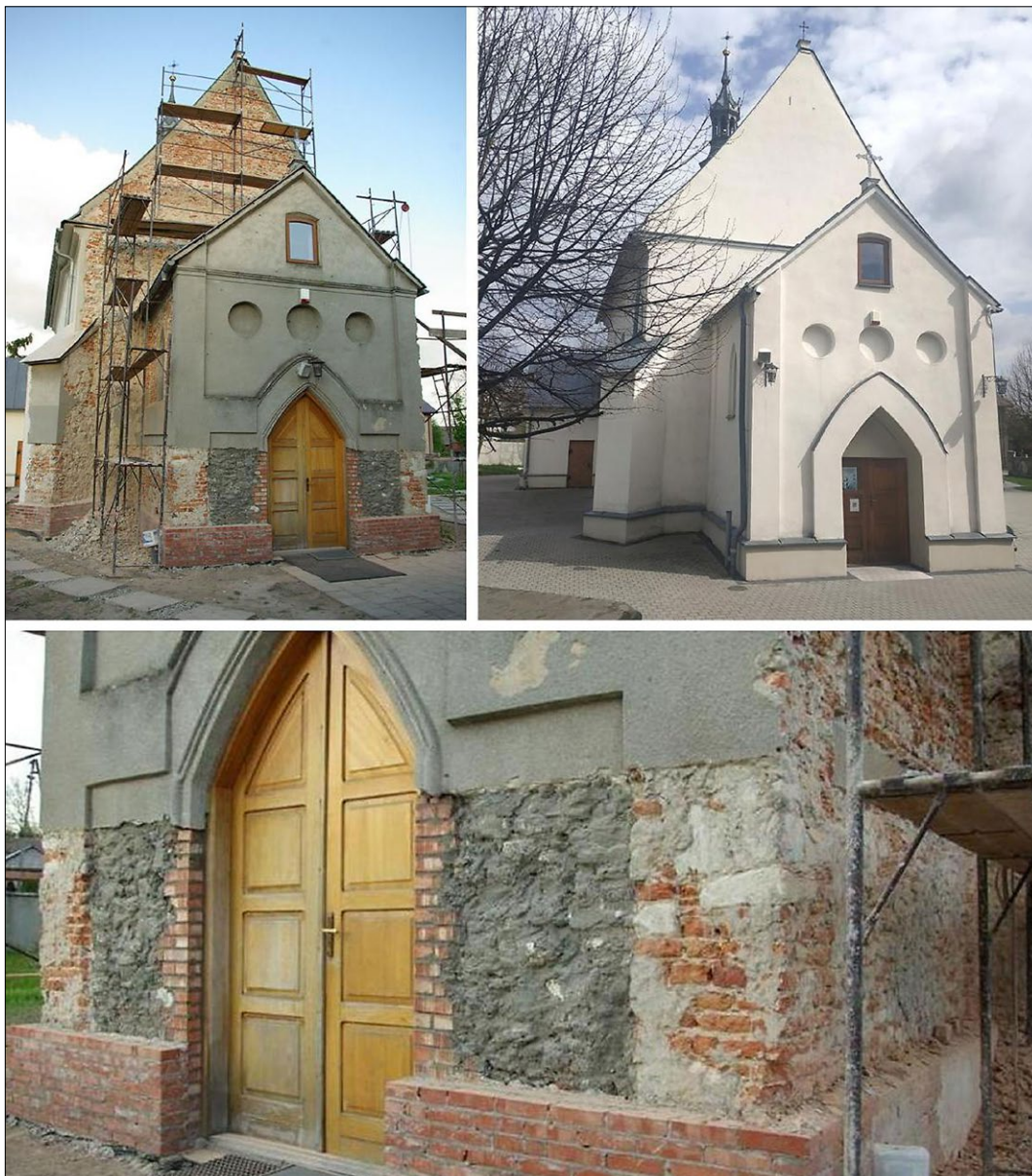
Ryc. 8. Widok elewacji zachodniej – frontowej w trakcie prac remontowo-konserwatorskich (2014) i współcześnie (2023); zbliżenie odkrytki na ścianie z widoczną strukturą wątku ceglanego; stan zachowania przed konserwacją; sierpień 2014, kwiecień 2023.
