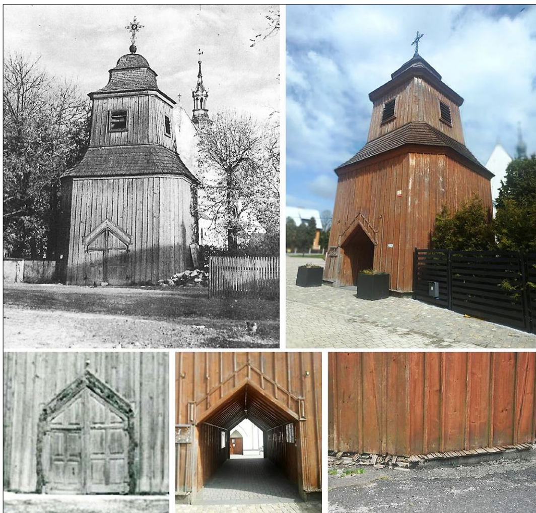
Ryc. 10. Sylweta bryły z detalem bramnym wejścia w widoku od rynku z lat. 70. XX w. [Archiwum Parafii 2022] i współcześnie, w 2023; fragment dolnej części dzwonnicy – stan zachowania przed konserwacją; 1990, 2023.
