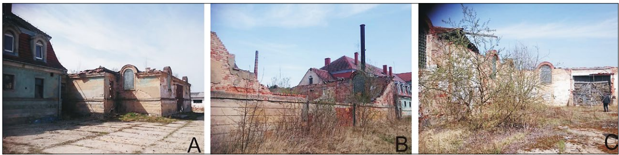
Ryc. 3. Budynek dawnej ujeżdżalni koni zespołu folwarcznego w Kochcicach (stan z 2018): A – widok od strony północnej, od dziedzińca wewnętrznego zabudowy; B – widok od strony południowej; C – widok wnętrza budynku; fot. M. Brus.
