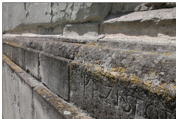
Ryc. 8. Fragment profilowanego zwieńczenia cokołu wschodniej elewacji prezbiterium, 2022.
