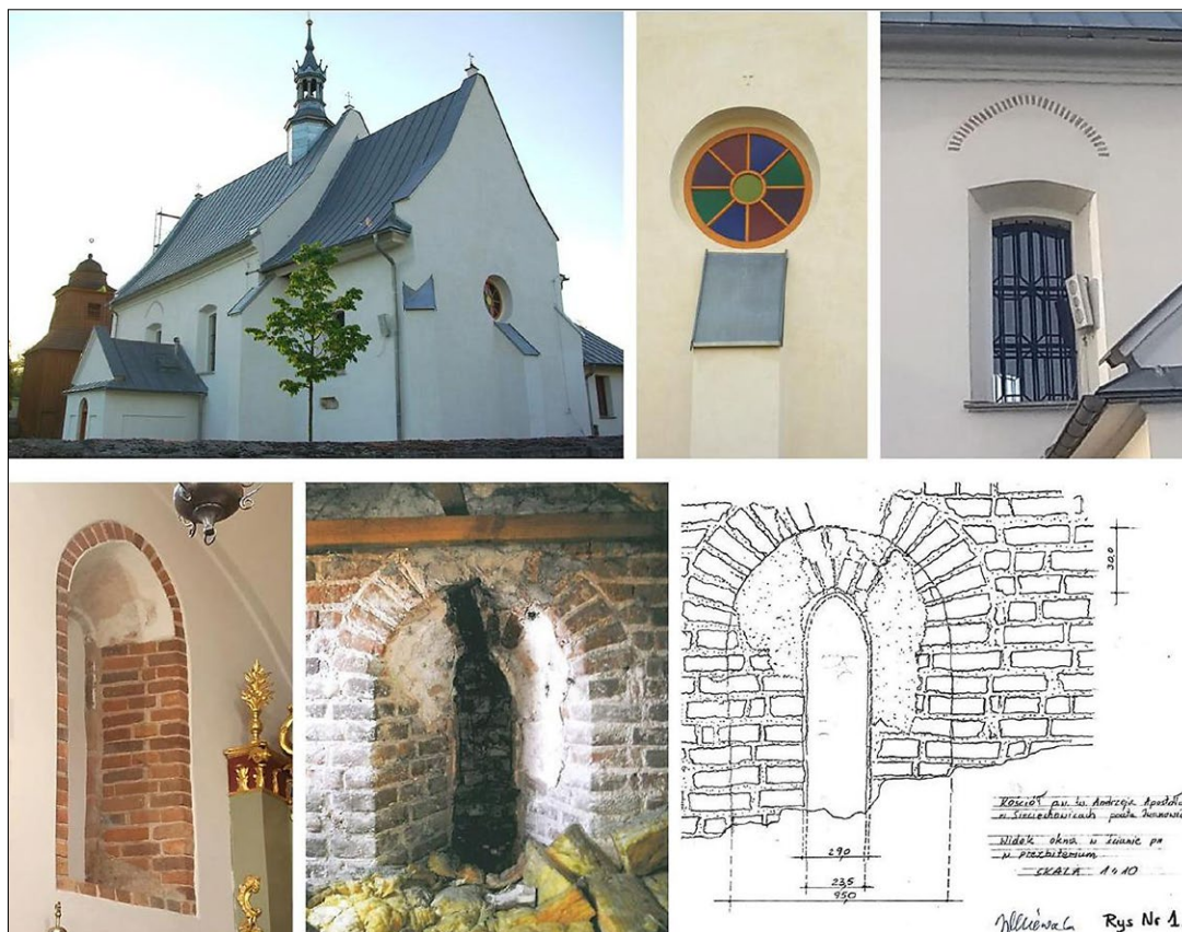
Ryc. 9. Bryła kościoła w widoku ogólnym na prezbiterium i ścianę południową; detale zewnętrzne odsłoniętego okna w ścianie zachodniej prezbiterium i okna z odsłoniętym ostrołukiem ceglany w elewacji południowej; detale okna gotyckiego w ścianie północnej prezbiterium od wnętrza kościoła i w widoku pod dachem nad zakrystią; inwentaryzacja okna; kwiecień 2023; [„Opinia konserwatorsko-badawcza” 2014].
