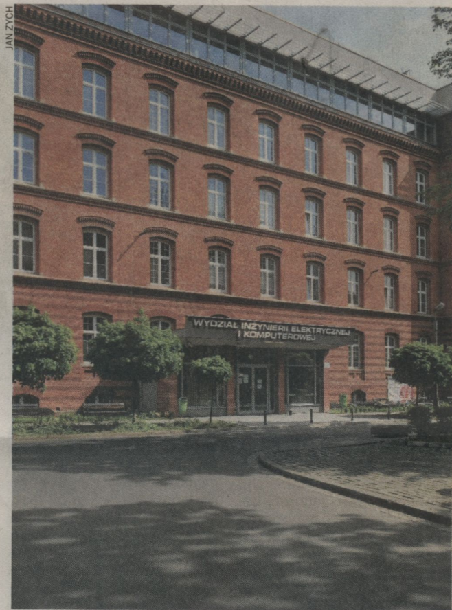
Siedziba Wydziału Inżynierii Elektrycznej i Komputerowej
