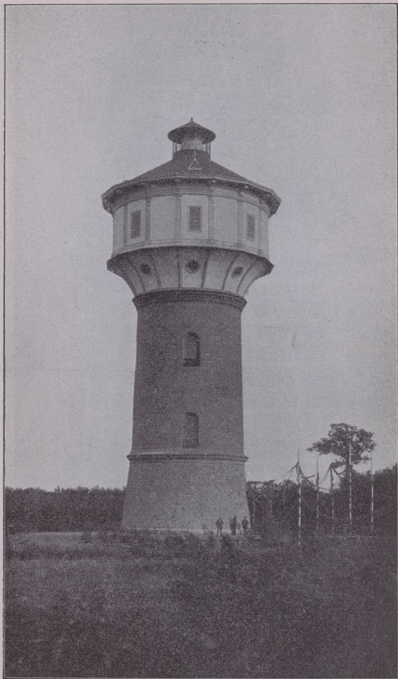
Wasserturm der städtischen Wasserwerke Wandsbeck bei Hamburg. Ummantelung des Wasserbehälters nach System Monier.
