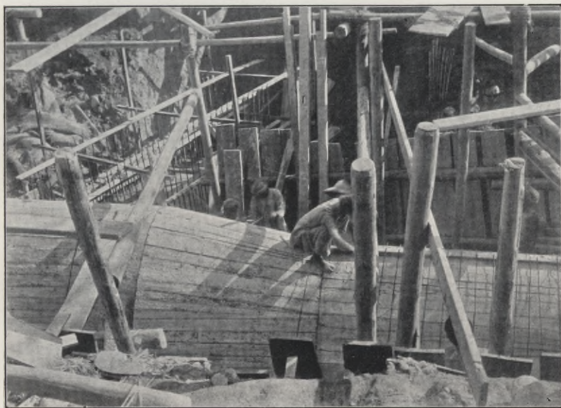
Bau eines Sammelkanals aus Eisenbeton
