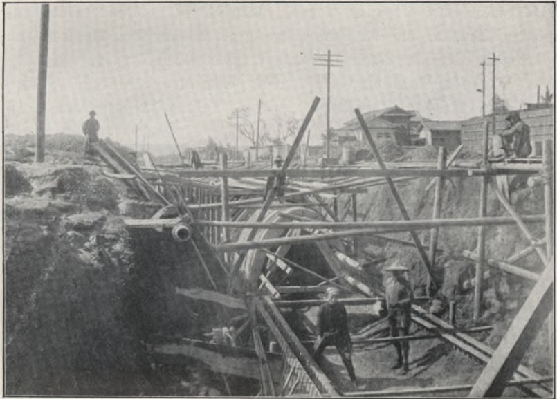
Bau eines Sammelkanals aus Eisenbeton: ein fertiger Teil
