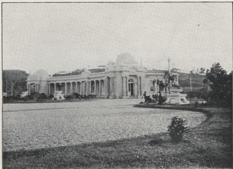
Wasserwerk der Stadt Taihoku: Pumpstation
