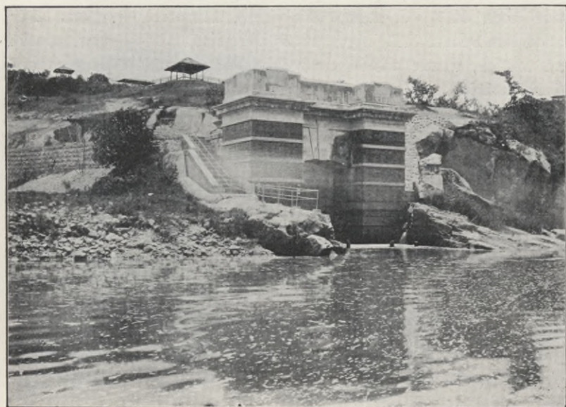
Wasserwerk der Stadt Taihoku: Wasserentnahmestelle
