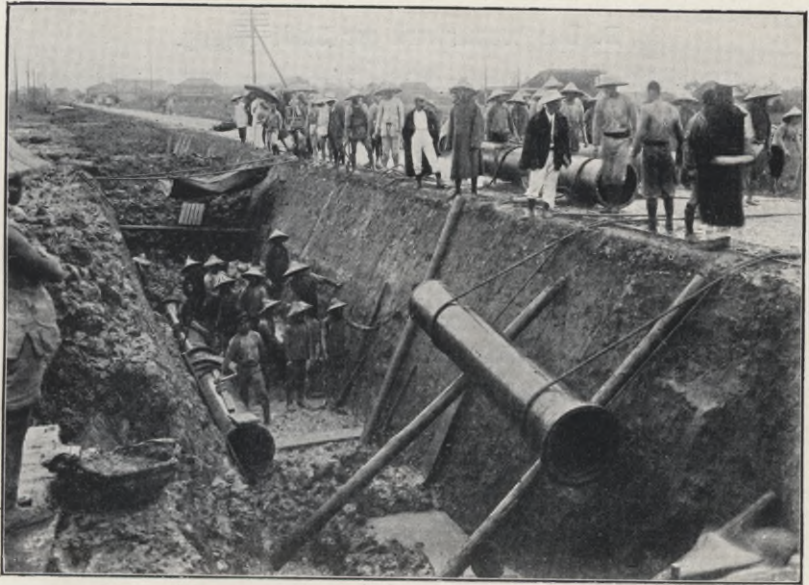
Legen der Leitungsrohre in der Stadt Taihoku
