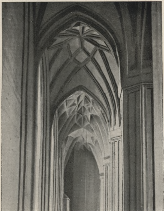
38. Gewölbe, im nördlichen Seitenschiff der Bernhardinerkirche
