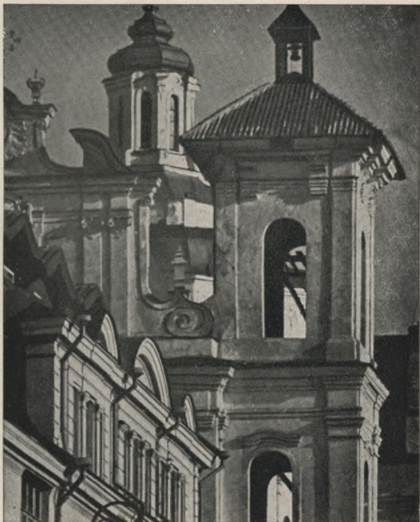
67. Teilansicht vom Oberbau der Dominikanerkirche
