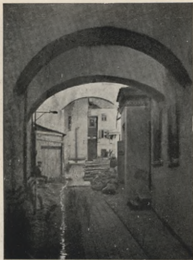
130. Hofdurchgang im Judenviertel
