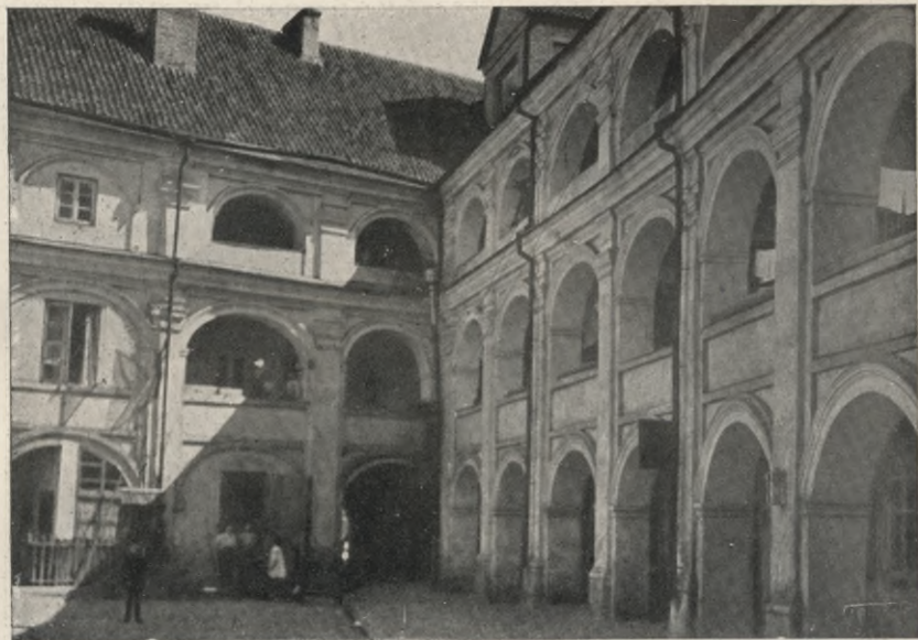
48. Der Alumnatshof mit dreigeschossigen Bogengängen
