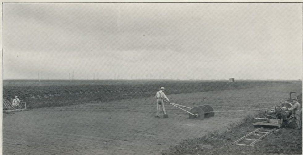
Bild 6. Schneiden des mit Handschneider vorgeschrittenen Torfkuchens. (Elektrisch betriebene Winden ziehen den Torfschneider über das Moor.)
