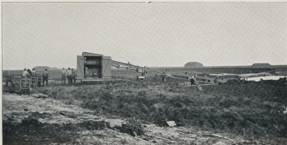
Bild 5. Torf-Formmaschine (System Dolberg). Lieferung 60 000 bis 80 000 Soden bei 10-stündiger Arbeit.
