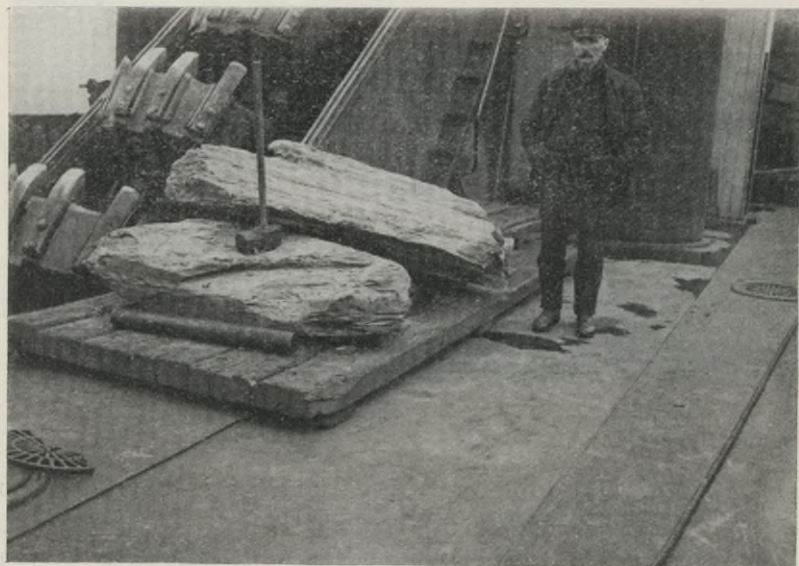
Schiefergestein ohne Hilfe von Sprengstoffen ausgebaggert.
