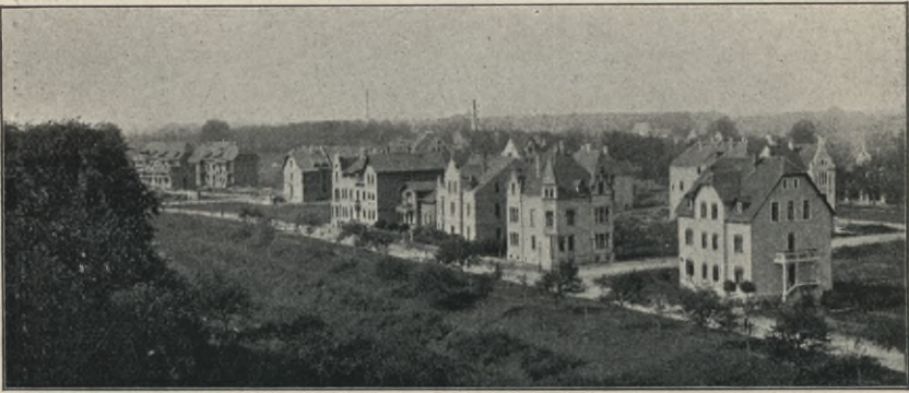
Abb. 68. Die Friedrichstraße (von der Sternwarte des Realgymnasiums aus gesehen).
