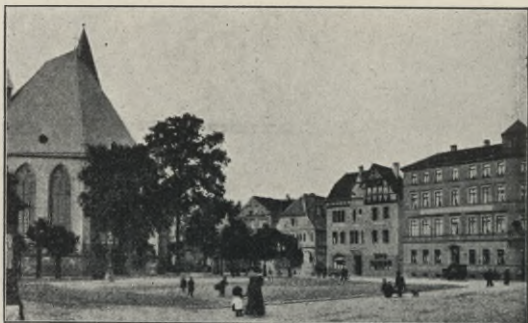
Abb. 48. Marktplatz, Ansicht von Süden.
