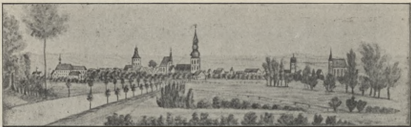
Abb. 31. C. T. Bauch, Lippstadt, nördliche Ansicht.
