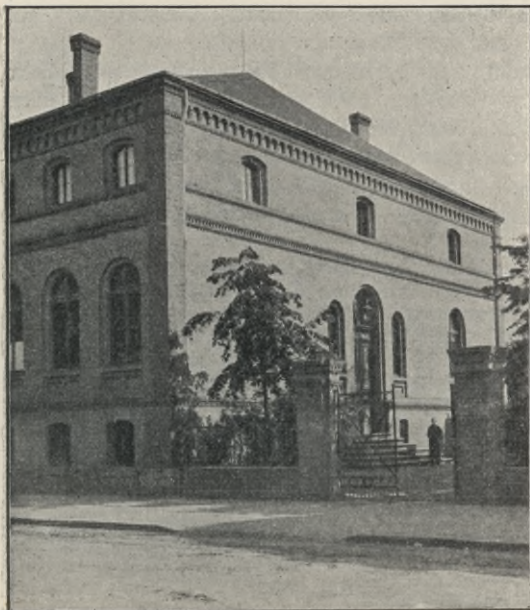
Abb 103. Gebäude der „Eintracht-Gesellschaft“.
