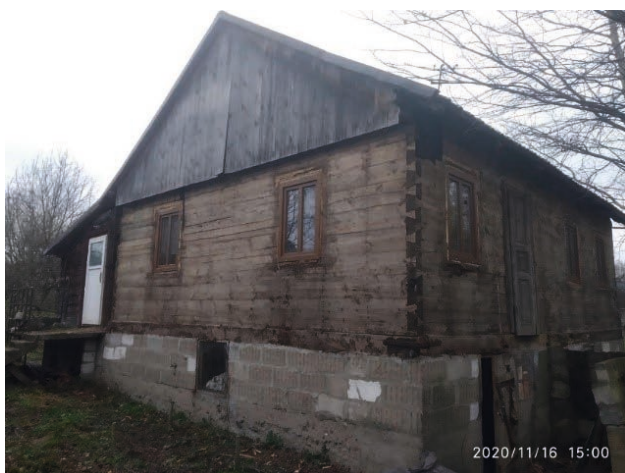
II. 3. Widok domu po demontażu szalówki, źródło: ze zbiorów prywatnych właściciela.
