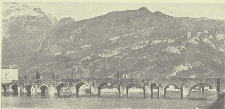
Il ponte Azzone Visconti.
