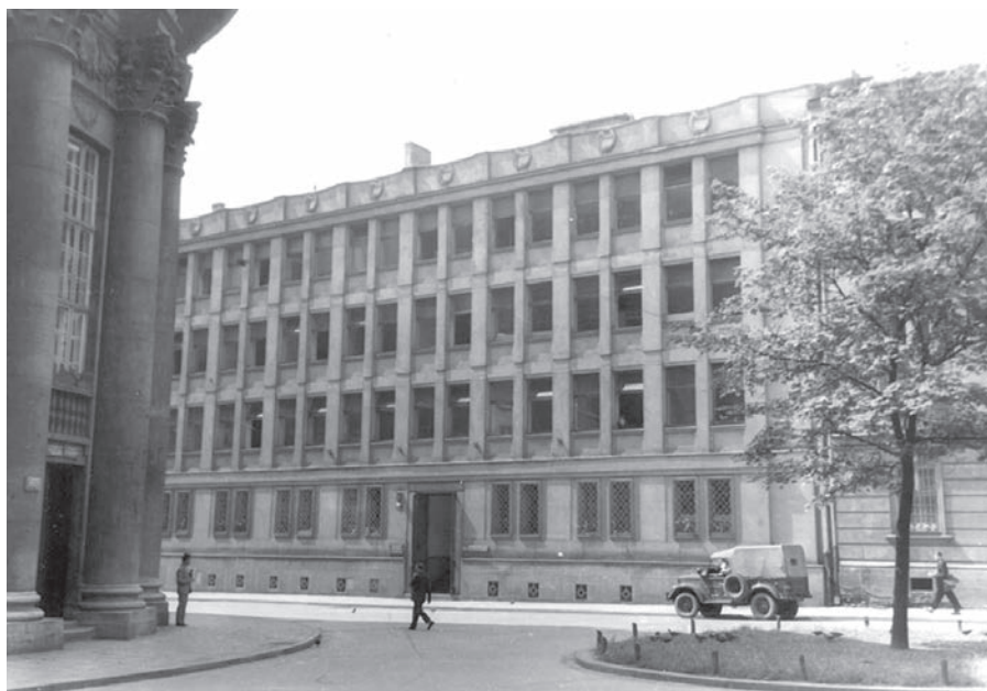
Biurowiec KBPBP przy ulicy Wielopole 17 w Krakowie; architekt: Bohdan Lisowski, 1950–1952. Fot.: Bohdan Lisowski
