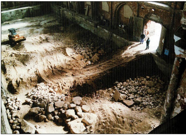
Ryc. 4. Widok nawy kościoła po wykonanych pracach archeologicznych, już bez filarów międzynawowych, 1995; [Fenske 1998, s. 28]. Fig. 4. View of the nave of the church after archaeological exploration, already without the inter-nave columns, 1995; [Fenske 1998, p. 28].
