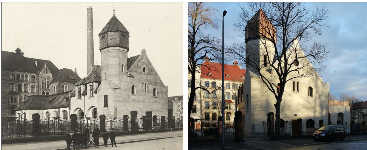
Ryc. 11. Laboratorium maszynowe (obecnie E-3, Biblioteka Architektury Politechniki Wrocławskiej) ok. 1907 [Biblioteka Uniwersytecka we Wrocławiu, sygn. 818] oraz po częściowej rekonstrukcji w latach 2015–2016, 2017; fot. A. Gryglewska.
