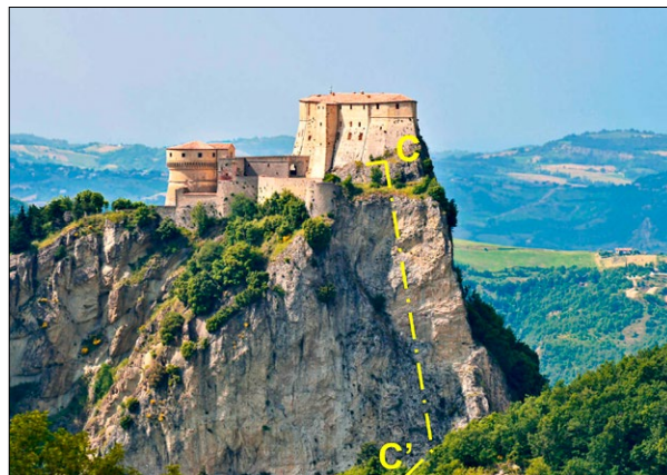
Ryc. 6. Widok wschodniego klifu z zaznaczonym przekrojem C-C', 2015.
