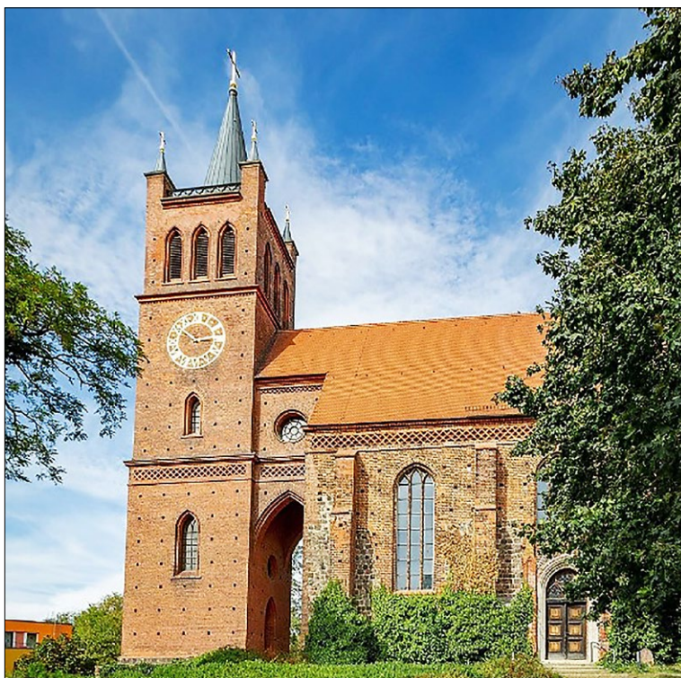
Ryc. 7. Kościół NMP w Neubrandenburgu, widok na południową elewację; [Stadt-pfarrkirche St. Marien, Müncheberg].
