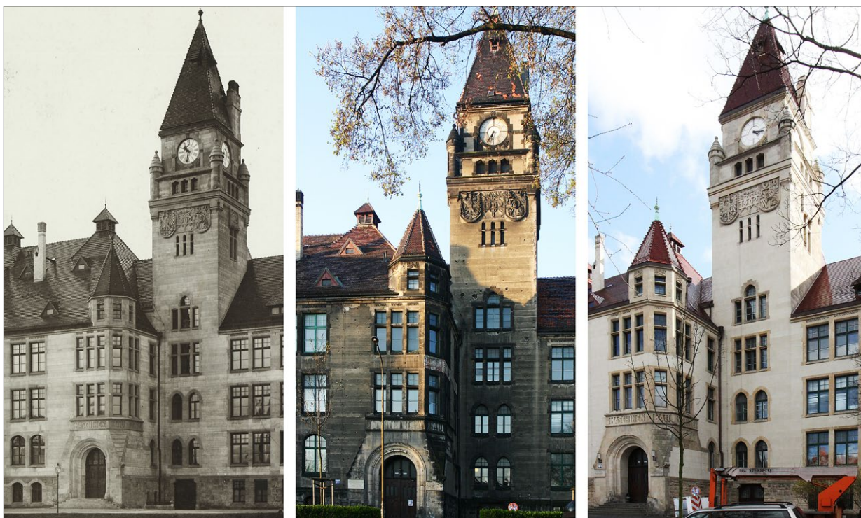
Ryc. 2. Fragment fasady budynku E-1 w 1904 [Biblioteka Uniwersytecka we Wrocławiu, sygn. 1168]; stan przed remontem w 2008; stan po remoncie elewacji i dachu w 2015; fot. współczesne A. Gryglewska.
