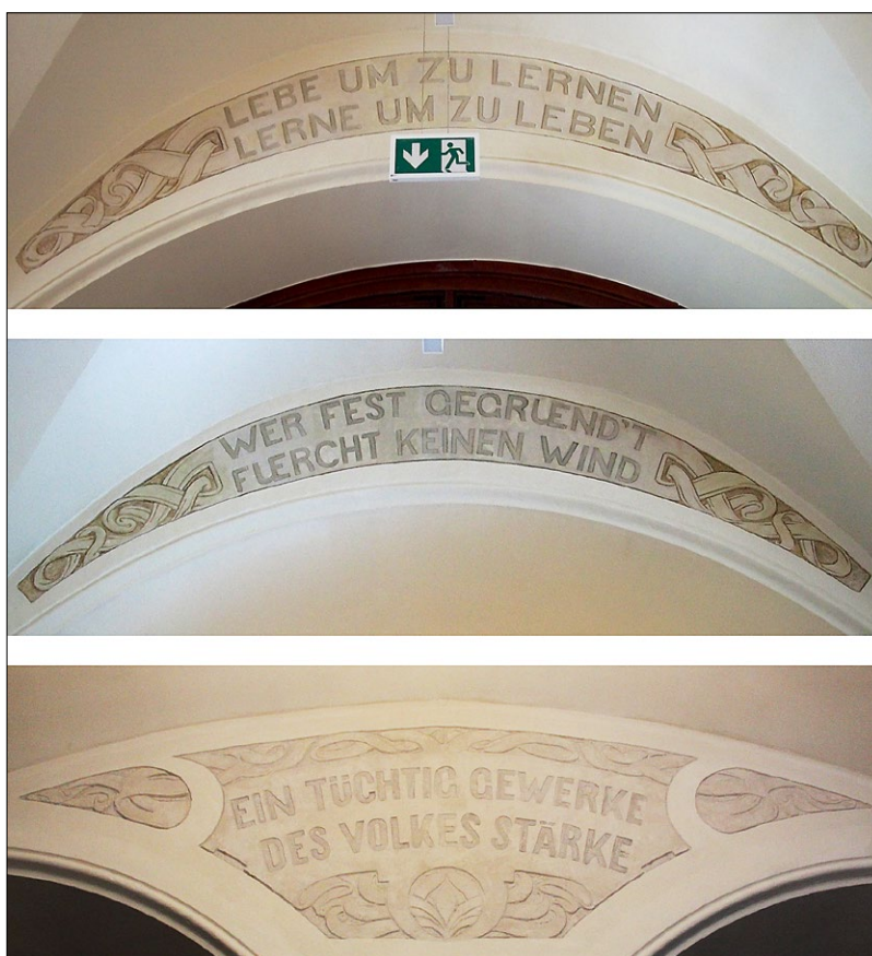
Ryc. 4. Wykonane w zaprawie reliefy z sentencjami odsłonięte na korytarzu I piętra i w holu na parterze budynku E-1 po ukończeniu prac konserwatorskich w styczniu 2019; fot. D. Oleś.
