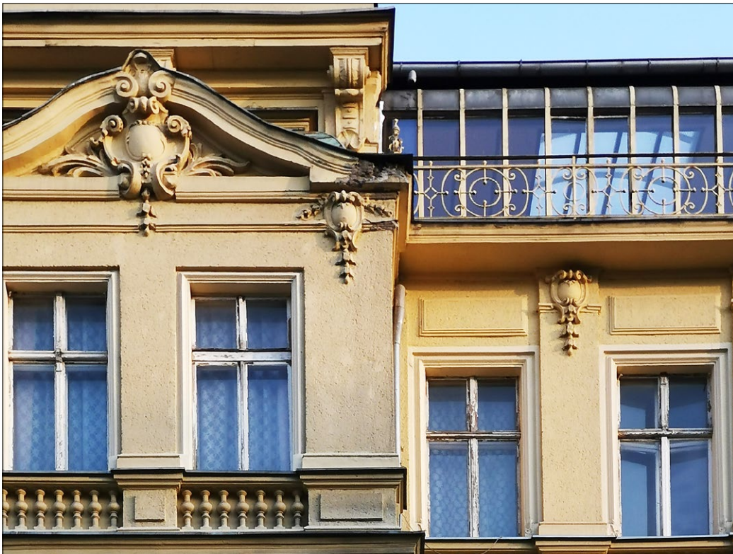
Ryc. 7. Altana fotograficzna przy ul. Bałuki 24 z wysuniętym tarasem widokowym, 2020; fot. M. Szymanik.
