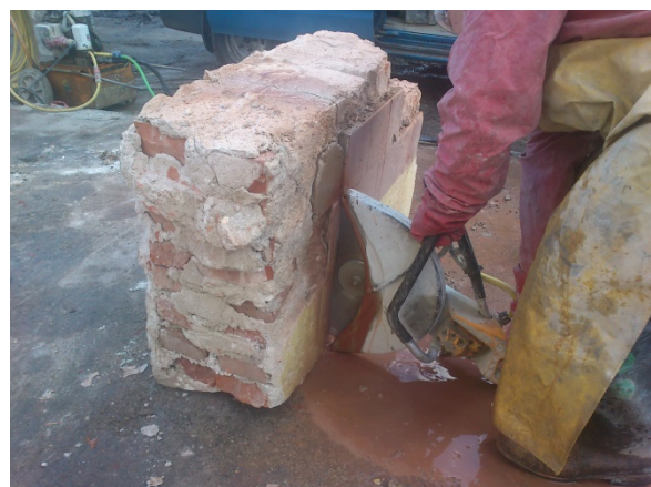
Rys. 6.2 Etap wycinania filarów murowych
