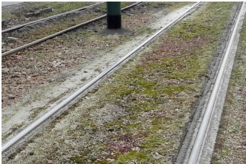
Rys. 2.26. Nadmierne zgromadzony piasek przy szynach [źródło własne]
