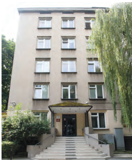
Dom Studencki „Pod Przewiązką” przy ulicy Bydgoskiej przejdzie gruntowny remont
