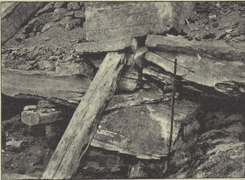
Tempel von Karnak. Corrodierter Wandsockel im SO.-Theil.
