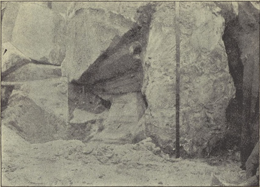
Tempel von Karnak, Thutmosisbau. Corrodierter Säulenfuß.
