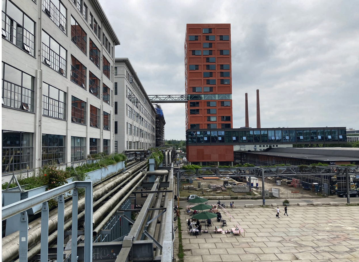
II. 5. Widok na wieżę mieszkalną Haasje Over połączoną kładką z budynkiem Anton. Autor: KatVanHuis. Źródło: https://upload.wikimedia.org/wikipedia/commons/3/3b/Haasje-2021.jpg (dostęp: 06.02.2024), CC BY-SA 4.0 < https://creativecommons.org/licenses/by-sa/4.0/ >, via Wikimedia Commons.
