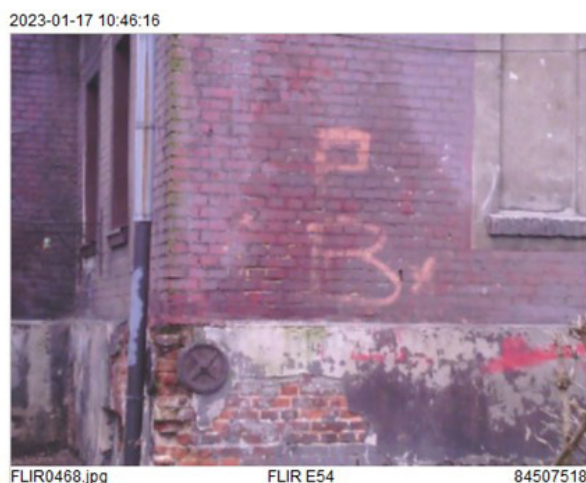
II. 16. Badanie termowizyjne fasad familoków w Bytomiu, Bobrku – widoczny podwójny efekt temperaturowy – silne zawilgocenie i efekt naroża, klatka schodowa nieogrzewana. Fot. M. Krause-Świerczyńska, 01.2023
