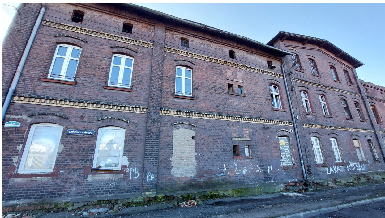
II. 9. Budynek objęte badaniami na terenie osiedla Bobrek przy ulicy L. Pasteura, Fot. M. Krause-Świerczyńska, 01.2023
