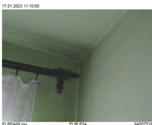
II. 20. Badanie termowizyjne fasad familoków w Bytomiu, Bobrku – fragment mieszkania na parterze jak na termogramie powyżej – typowy mostek przestrzenny o niskiej izolacyjności cieplnej, Sp1 = 12,7°C, Sp2 = 16,8°C, Sp3 = 15,0 °C, Sp4 = 16,7 °C. Fot. M. Krause-Świerczyńska, 01.2023
