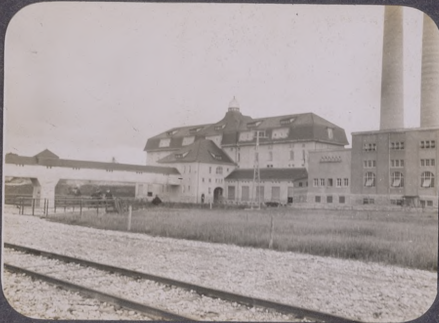
5. Wyhlen, Schalthaus m. Dampfreserve.
