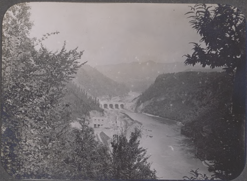
37. Robiate, Wehr u. Einlauf z. Wehrkanal.
