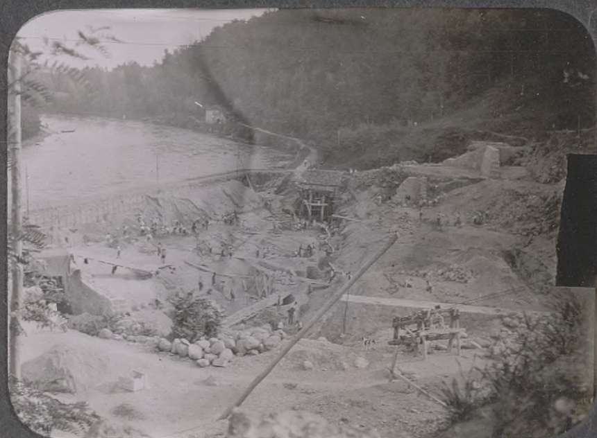
40. Robiate, Krafthaus im Bau.
