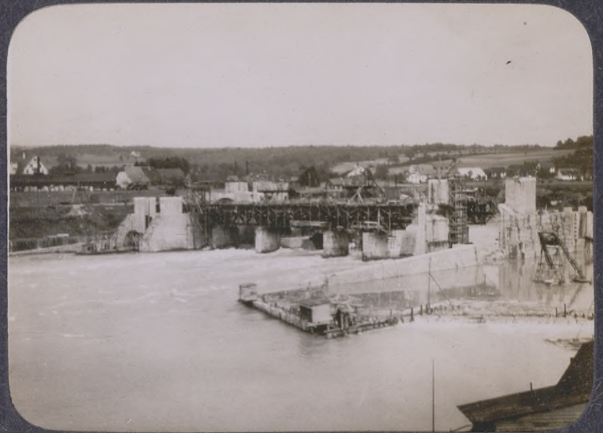
6 Laufenburg, Wehr im Bau.
