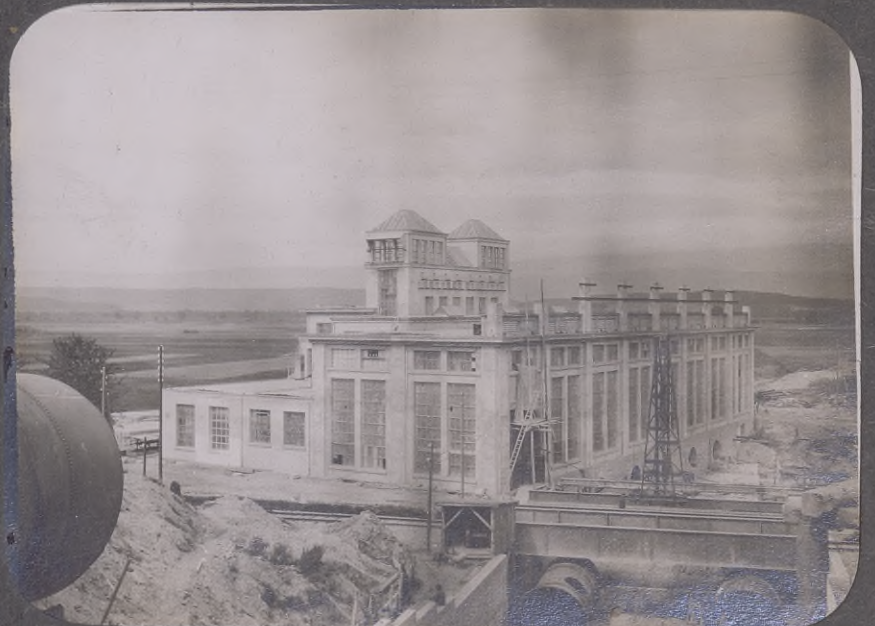
12. Kallnach, Krafthaus im Bau.
