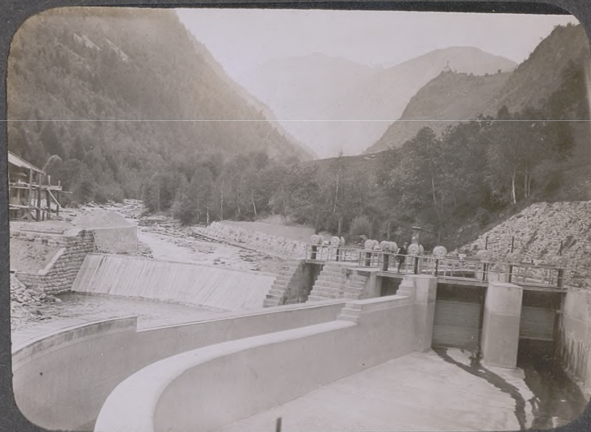
46. Schnalstalwerk, Wehr mit Einlauf und Sandfang.
