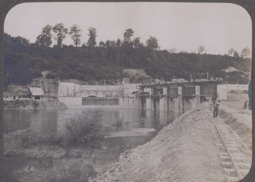
10. Kallnach, Wehr m. Stolleneinlauf.
