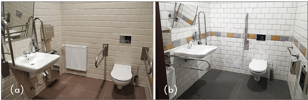
Ryc. 2. Nowa toaleta uniwersalna w zabytkowym budynku dworca kolejowego: (a) w Chojnowie, (b) w Żaganiu; autorką wszystkich fotografii jest A. Santorowska.
