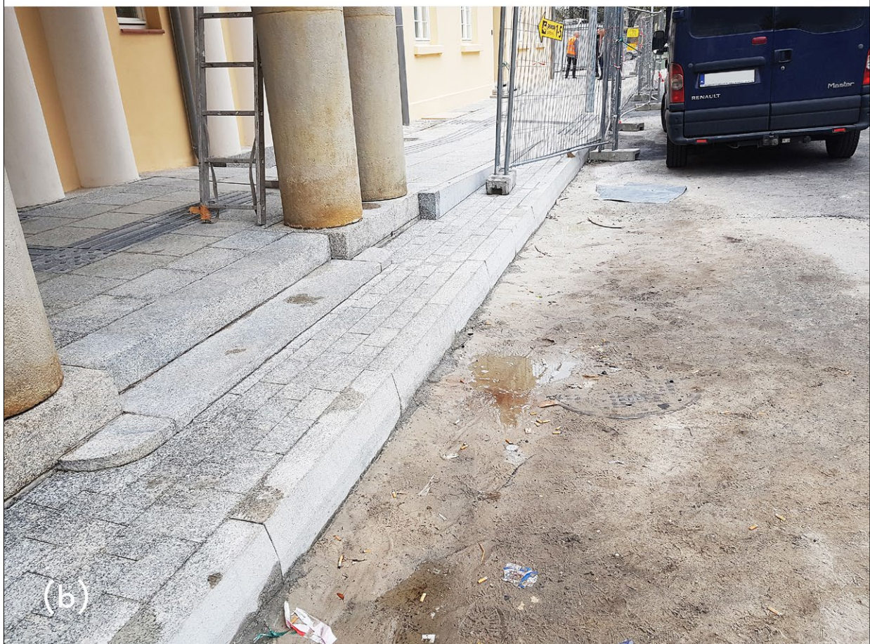
Ryc. 5. Wejście główne dworca kolejowego w Żaganiu: (a) przed przebudową, (b) po przebudowie. Fig. 5. Main entrance to the Żagań train station: (a) before the remodel, (b) after remodeling.
