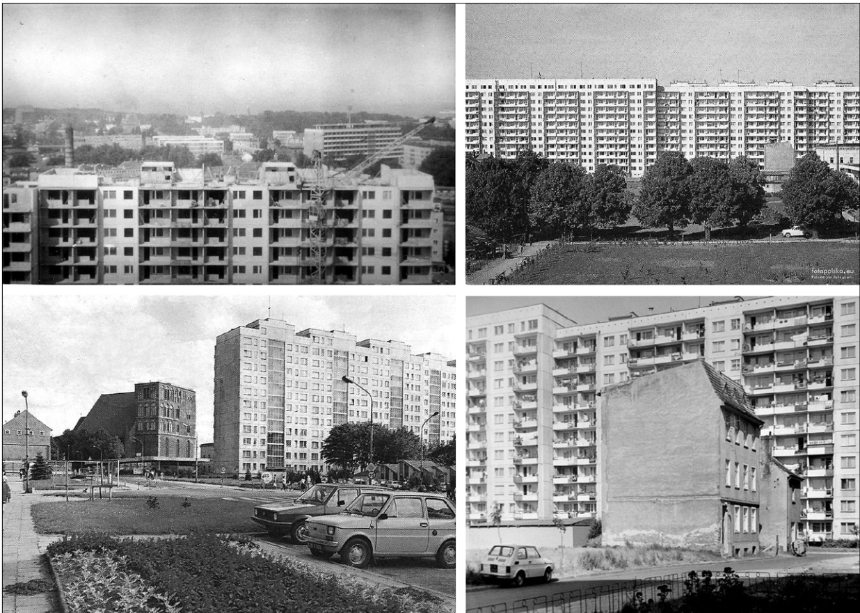
Ryc. 7. Budowa bloków mieszkalnych przy ul. Wąskiej – lata 70. i 80. XX w.; [ https://latarnia-morska.eu/pl/rozmowa-latarni/2076-koobrze-ska-starowka-pena-ycia ; https://www.facebook.com/profile/100063132583999/search/?q=w%C4%85ska ].
