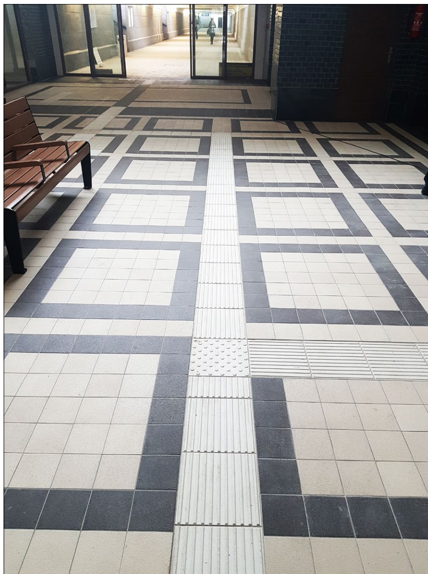
Ryc. 9. Ścieżka dotykowa w odtworzonej posadzce dworca kolejowego w Żaganiu z wykorzystaniem wzoru posadzki w celu uzyskania kontrastu dla ścieżki prowadzącej.
