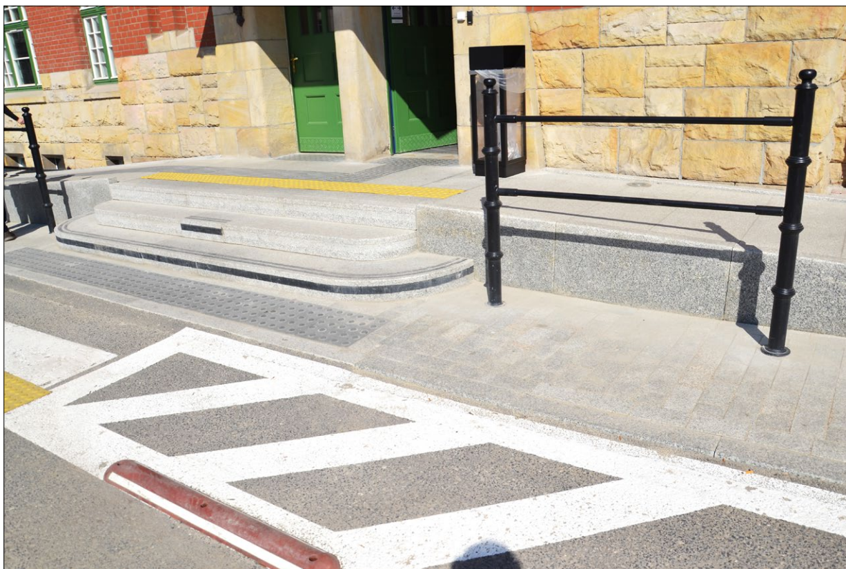
Ryc. 4. Wejście główne dworca w Chojnowie po przebudowie ze zintegrowaną pochylnią wjazdową. Fig. 4. The main entrance to the Chojnów station after remodeling, with an integrated entrance ramp.
