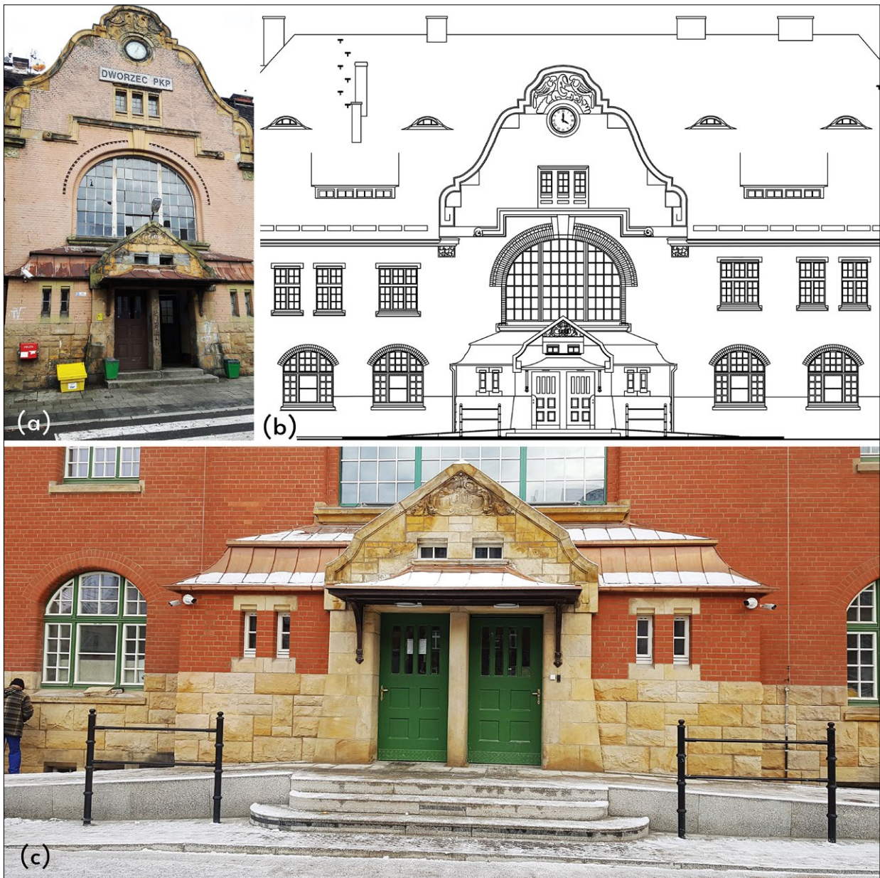
Ryc. 3. Wejście główne dworca kolejowego w Chojnowie: (a) przed przebudową, (b) według projektu przebudowy, (c) po przebudowie.
