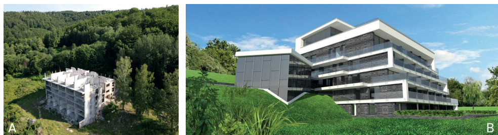
Il. 4. Punktowiec poddany rozbudowie i przebudowie na budynek mieszkalny. A – stan obecny, przekształcenie nie jest dokończone, 2024. Fot. aut.; B – wizualizacja przebudowy punktowca (Wyborcza.pl. Bielsko-Biała, 2018)
