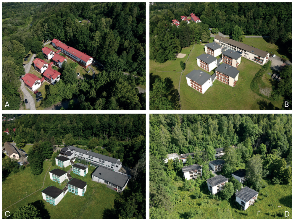
Il. 10. Widok z lotu ptaka na poszczególne gronowce, ukazujący ich przebudowę, 2024: A – zmiana dachu z jednospadowego na dwuspadowy, zmiana elewacji budynku, przebudowa bryły i zmiana charakteru, dodanie elementów zdobniczych, obcych dla całego zamierzenia modernistycznego; B – nadbudowa kondygnacji, zmiana dachu na dwuspadowy w module górnym liniowym; C – zabudowania w postaci szklarni-wykuszy, zmiana dachu na dwuspadowy w module górnym liniowym; D – budynek opuszczony, bez modyfikacji, zachowujący formę i detal pierwotnego założenia. Fot. aut.
