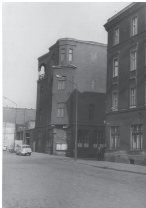
Il. 11. Hotel Kaiserhof po przebudowie przy ul. Stawowej 19 i ul. Młyńskiej, rok 1969 (Archiwum Muzeum Historii Katowic, sygn. MHKMP 42_10501)
