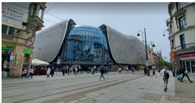
Il. 22. Galeria Katowicka, 2024. Fot. aut.
