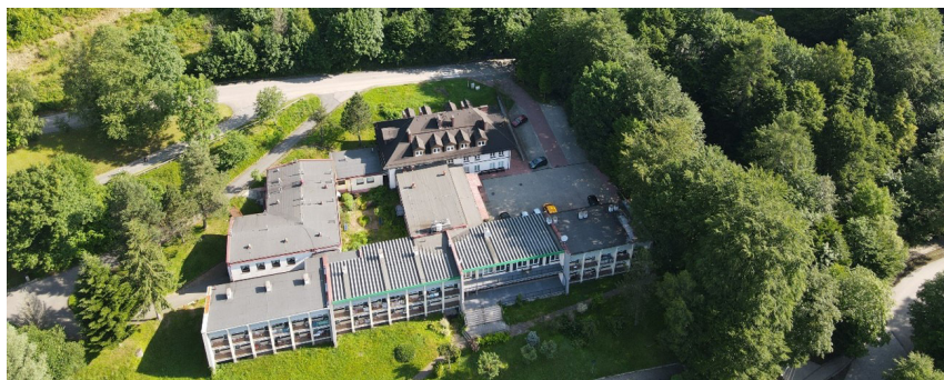
Il. 7. Rozbudowa budynku „Dąb”, 2024. Fot. aut.
