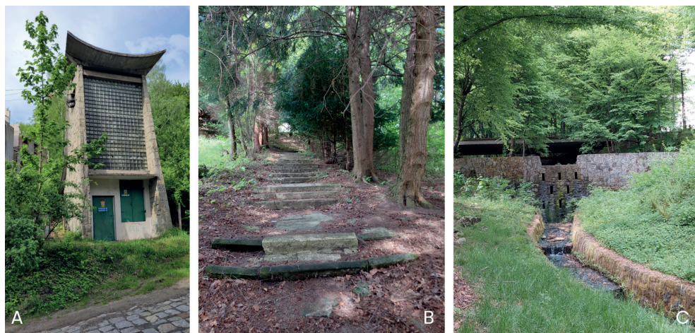
Il. 11. Elementy zagospodarowania terenu Jaszowca: A – trafostacja, B – schody łączące budynki, C – zapora na potoku Jaszowiec, 2024. Fot. aut.
