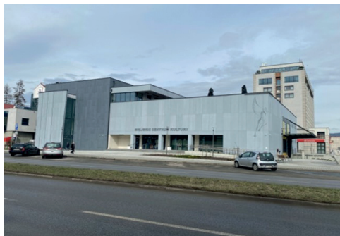
Il. 2. Widok Miejskiego Ośrodka Kultury w Nowym Targu po rewitalizacji. Fot. aut.
