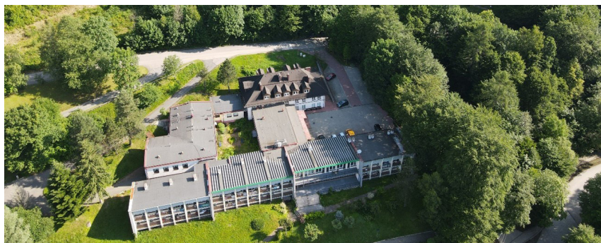
Il. 7. Rozbudowa budynku „Dąb”, 2024. Fot. aut.
