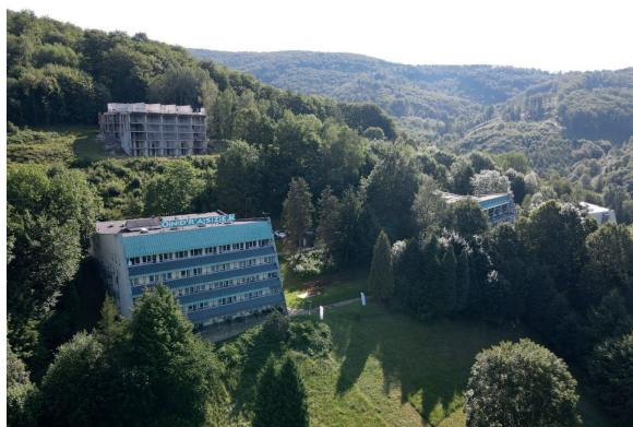
Il. 3. Widok z lotu ptaka, kadr podobny do historycznego (zob. il. 2), z przodu punktowiec „Ondraszek” – widoczny zabudowany został taras na ostatniej kondygnacji, w tle punktowiec w trakcie przebudowy na cele mieszkalne 2024. Fot. aut.
