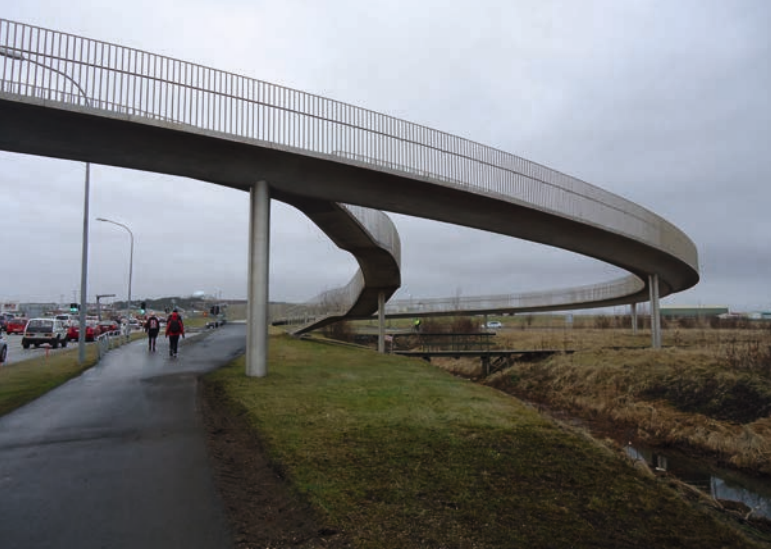
II. 12. Hringbraut Bridge w Reykjavíku. Fot. N. Przesmycka, 2016 r.
