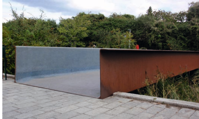
II. 4. Kładka stalowa nad kanałem w dzielnicy Ørestad. Fot. E. Przesmycka, 2015
