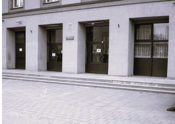
II. 5. Wejście do domu studenckiego III – al. Politechniki 7 Łódź. Widok wyposażonego w schody wejścia głównego niedostosowanego do potrzeb osób z niepełnosprawnościami. Autor: R. Przewłocka-Sionek, 2023
