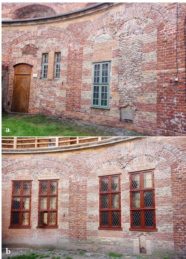
Ryc. 3. Ściana Wieńca: a) przed pracami, b) po ich zakończeniu; 2022, 2024
