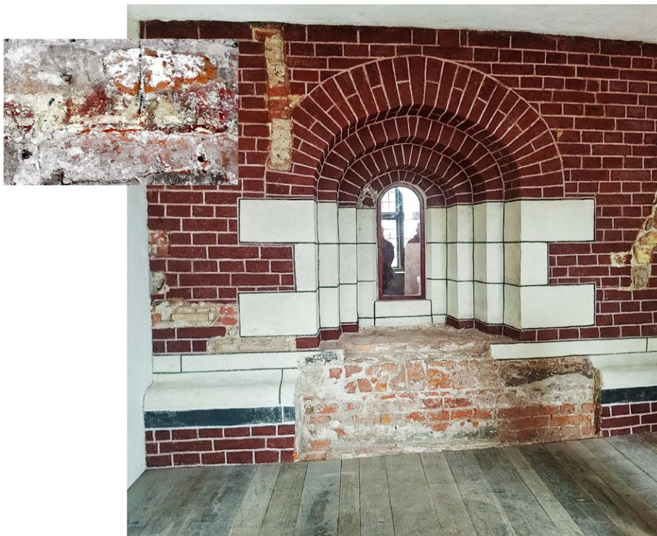
Ryc. 6. Wystrój barwny strzelnicy po pracach i odkrywka konserwatorska, 2018 i 2024 Fig. 6. Color scheme of embrasure after completion of work and conservation analysis of test area; 2018 and 2024
