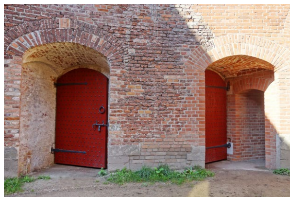
Ryc. 5. Zrekonstruowany przejazd igrekowy wraz z wrotami, 2024 Fig. 5. Reconstructed forked entrance with gates; 2024
