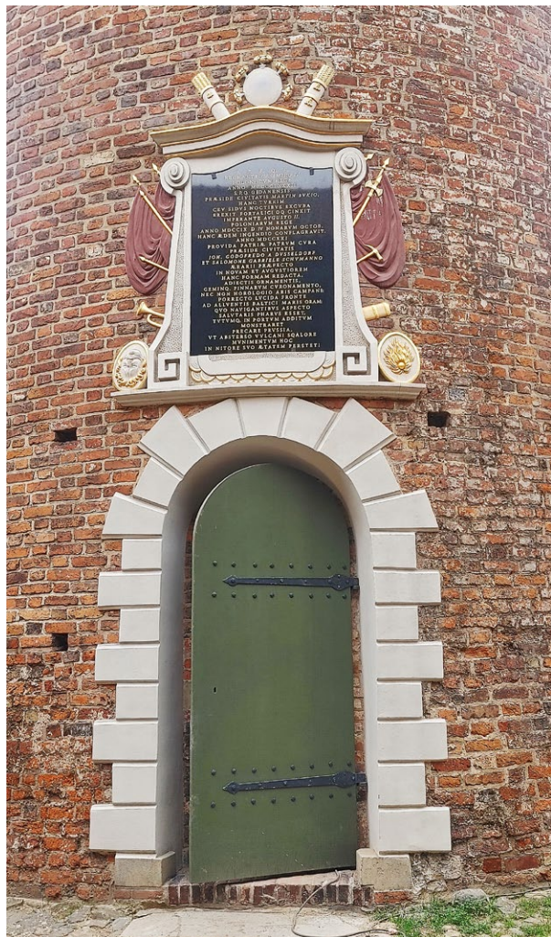
Ryc. 10. Portal i tablica z inskrypcją w latarni, 2024 Fig. 10. Lighthouse entrance with inscribed plaque; 2024
