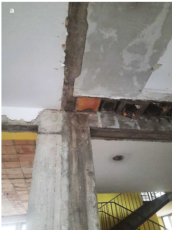
Ryc. 5. Konstrukcja budynku, widoczne: a) żelbetowe ramy układu konstrukcyjnego, b) strop Ackermanna; fot. P. Marciniak
