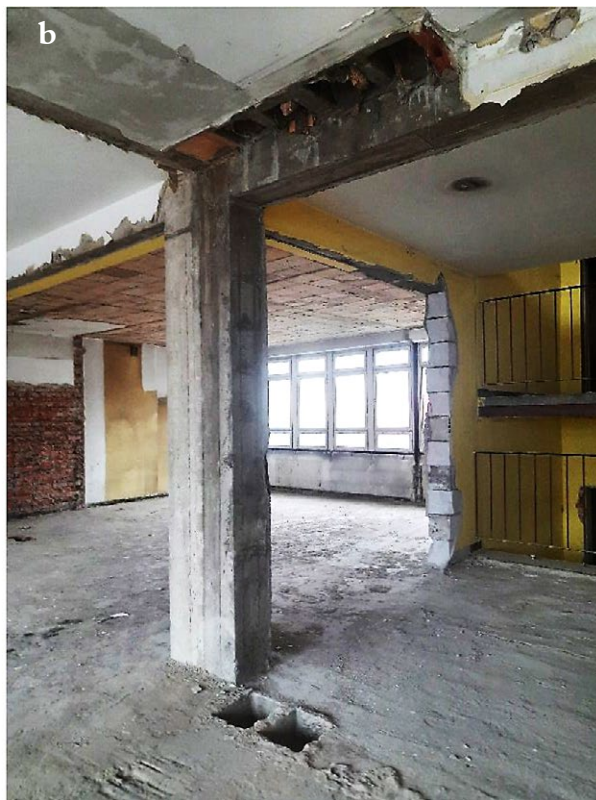
Ryc. 5. Konstrukcja budynku, widoczne: a) żelbetowe ramy układu konstrukcyjnego, b) strop Ackermanna; fot. P. Marciniak
