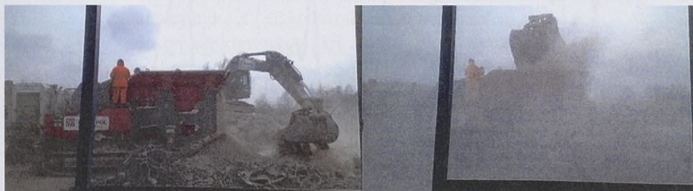
Rys. 13.11. Zaobserwowane zapylenie w otoczeniu kruszarki. Źródło: oprac. własne
