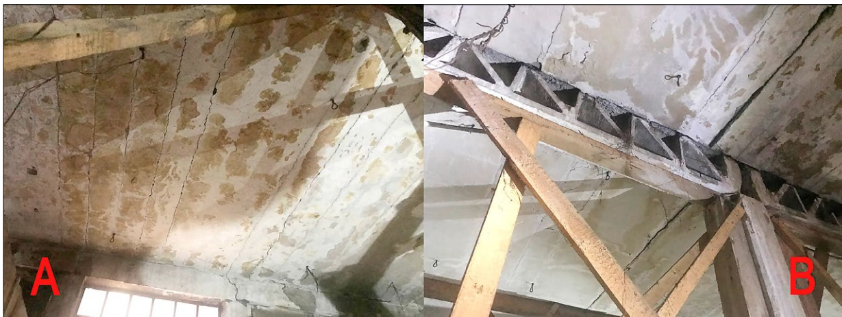
Ryc. 8. Fotografia stanu istniejącego: a) strop z dyli prefabrykowanych, b) podciąg nad I piętrem, 2023; fot. W. Bereza
