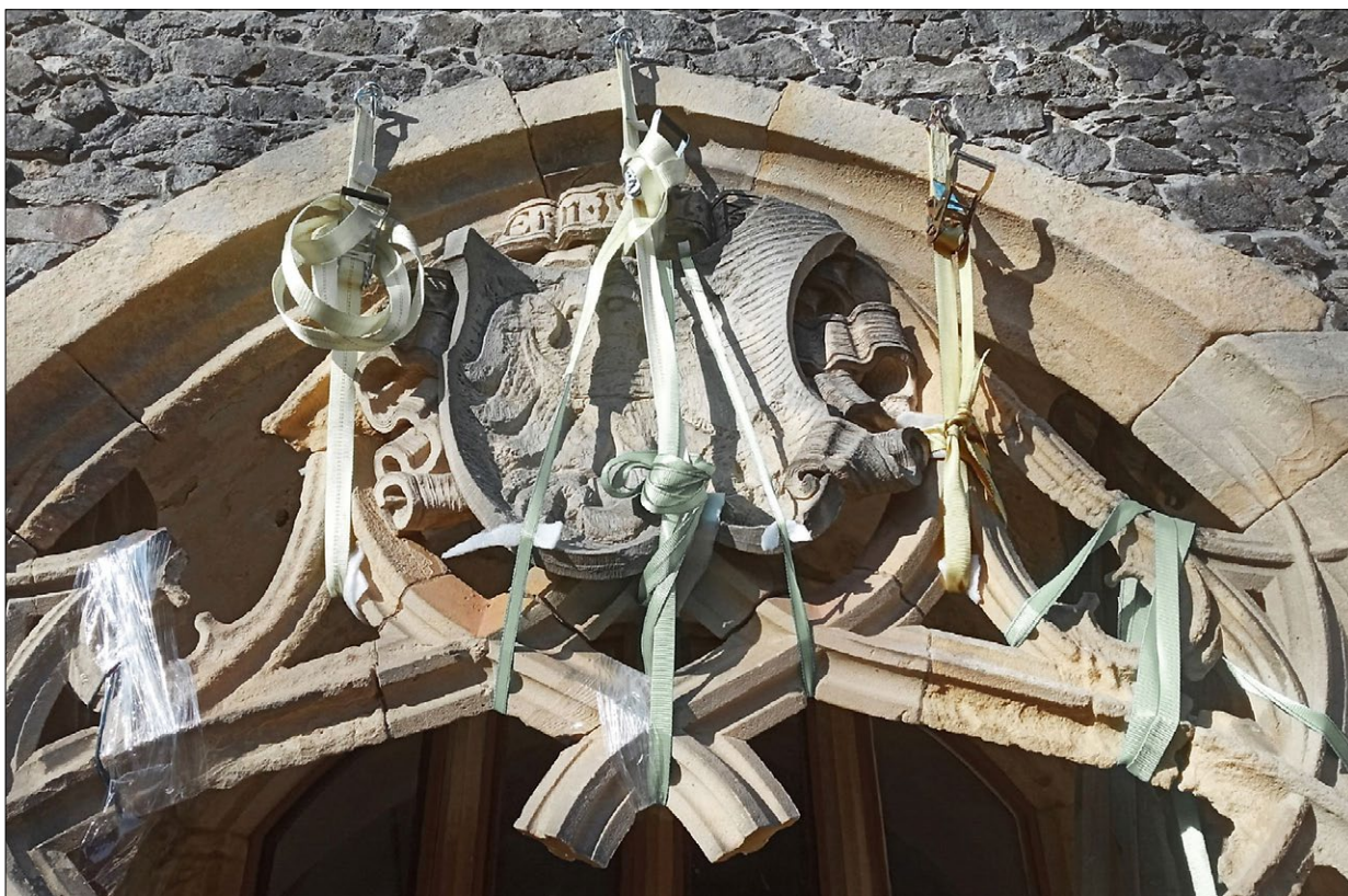
Ryc. 9. Dekoracja maswerkowa portalu podwieszona na zawiesiach pasowych, 2023; fot. J. Ciechanowska Fig. 9. Tracery decoration of the portal suspended on strip suspenders, 2023; photo by J. Ciechanowska
