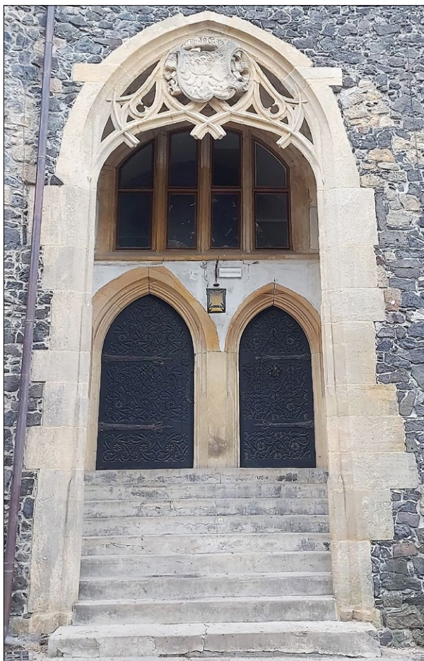
Ryc. 10. Stan zachowania piaskowcowego portalu wejścia głównego do palatium po konserwacji i restauracji, 2023; fot. J. Ciechanowska
