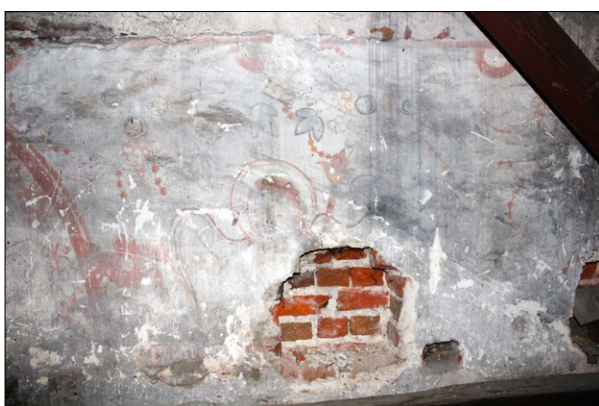
Ryc. 8. Kościół parafialny w Rychwale, północna część malowidła na zachodniej ścianie szczytowej (wizerunek anioła)
