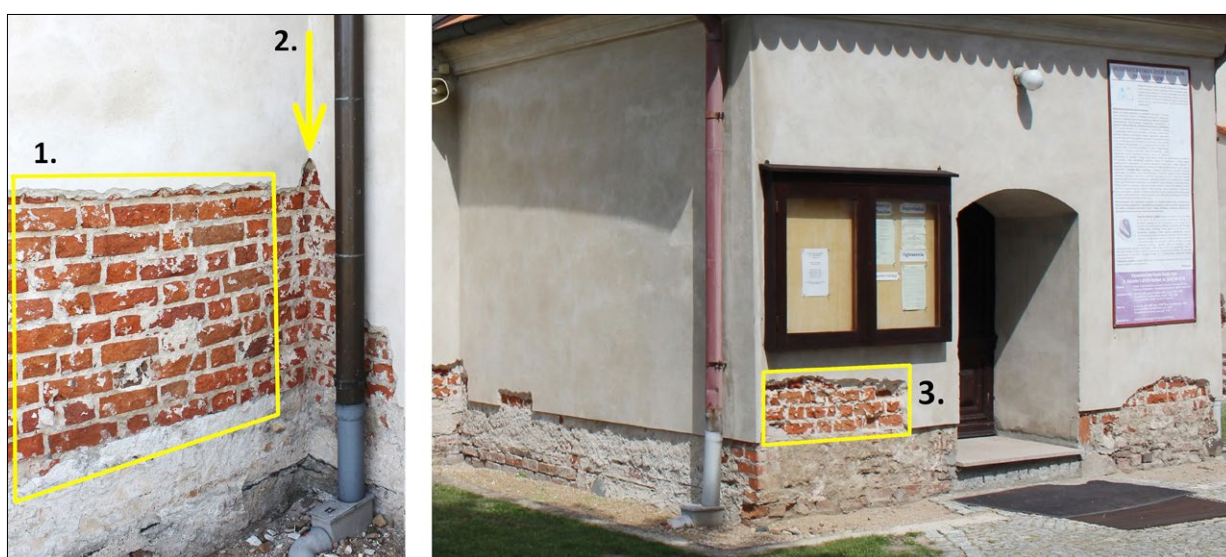
Ryc. 2. Kościół parafialny w Rychwale, widok gotyckiego wątku murarskiego apsydy (1) węzła architektonicznego apsydy i prezbiterium (2) oraz kruchty południowej z zaznaczonym wątkiem gotyckim elewacji (3); autorem wszystkich zdjęć w artykule jest W. Miedziak
