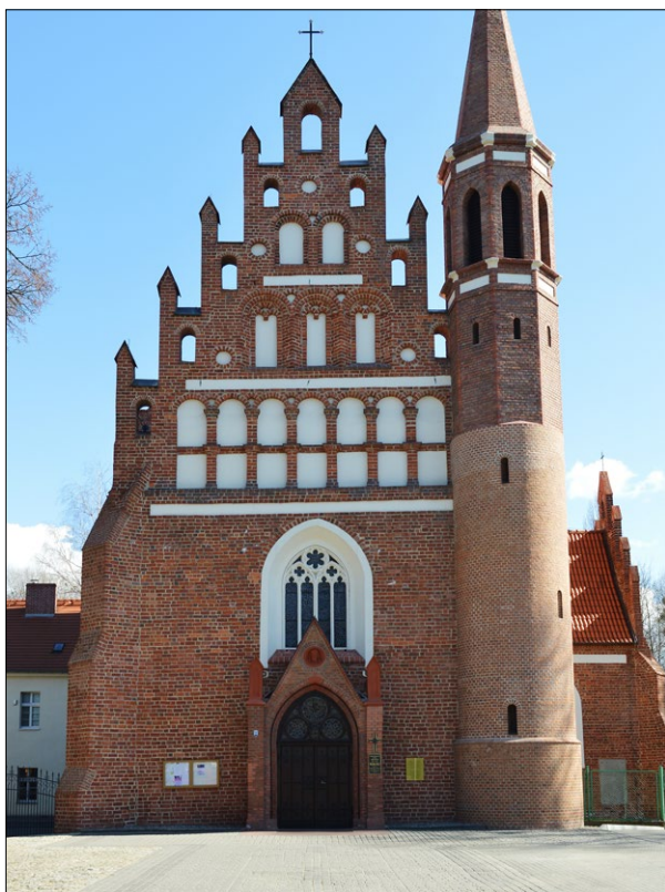
Ryc. 11. Kościół bernardynów w Bydgoszczy, fasada Fig. 11. Bernardine Church in Bydgoszcz, facade
