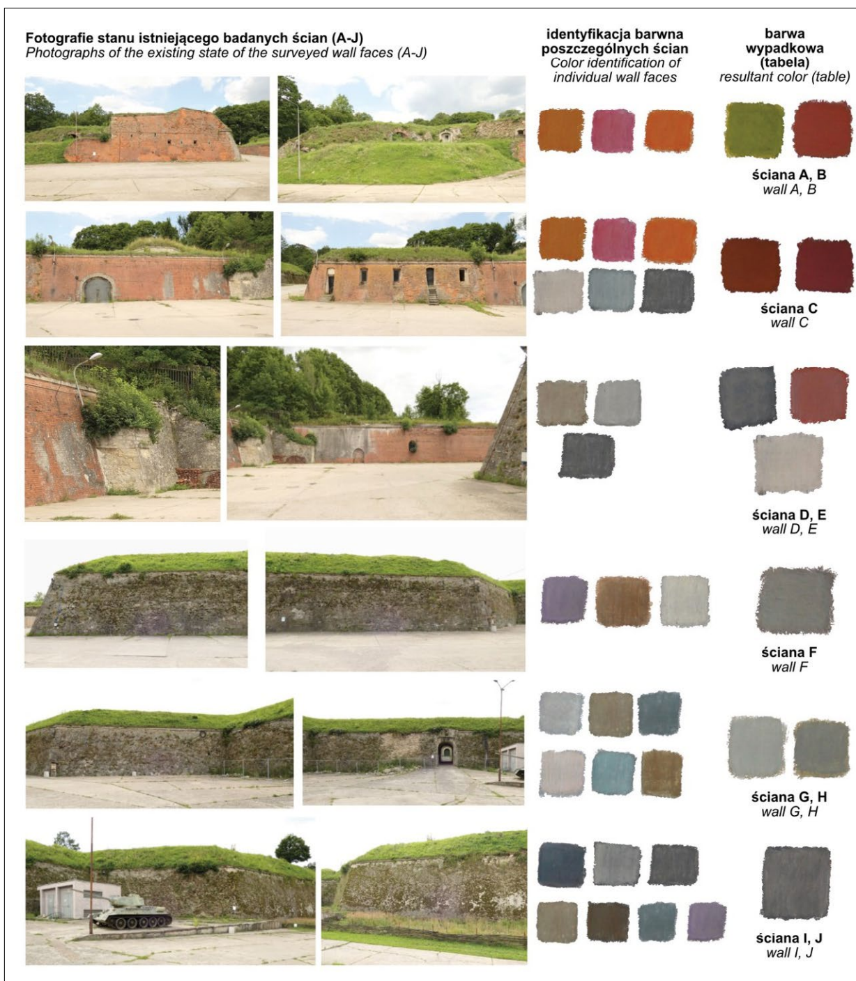
Ryc. 6. Brama i majdan (stan istniejący) – zestawienie próbek kolorystycznych poszczególnych ścian, tzw. wnętrzb urbanistycznych, wykonanych podczas badań in situ ; oprac. R.J. Balcerzak, K. Szumiński
