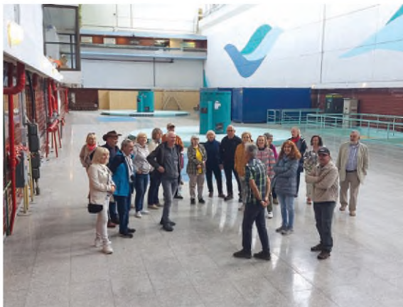
W Zespole Elektrowni Wodnych „Niedzica”
