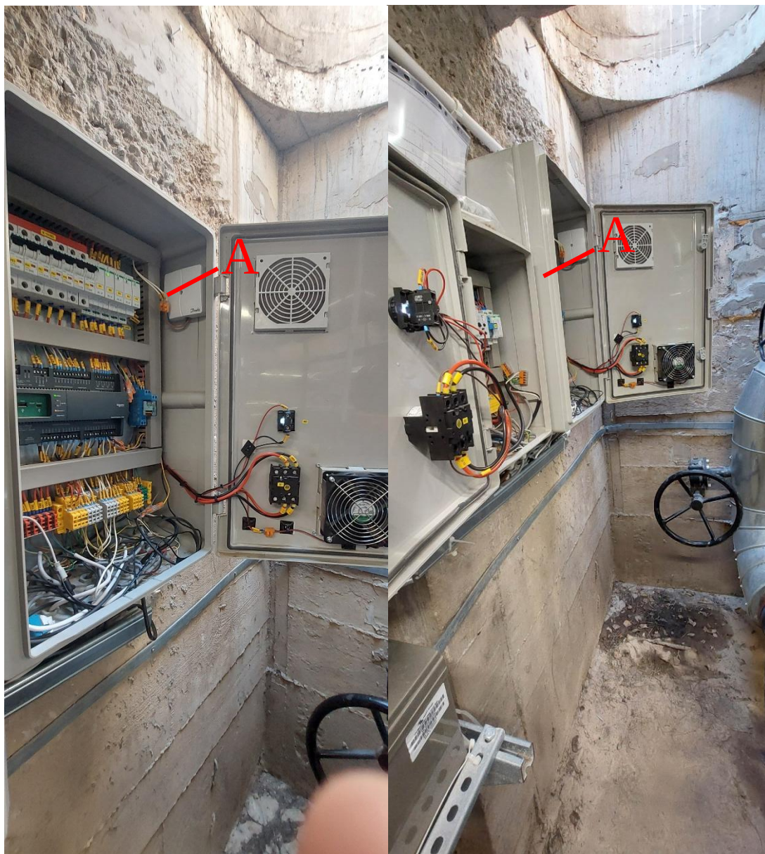
Rys. 13. Komora OFF-Grid po modernizacji: A - szafy elektryczne
