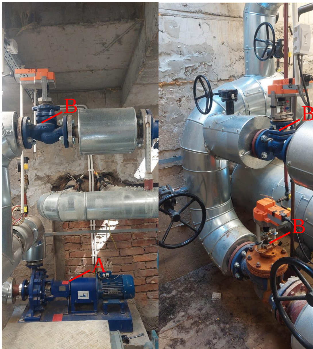
Rys. 12. Komora OFF-Grid po modernizacji: A - zespół turbina – generator, B - zawory z siłownikami
