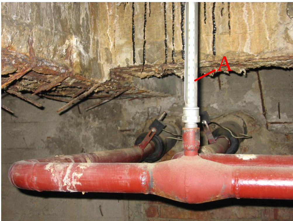
Rys. 3. Komora OFF-Grid przed modernizacją: A - termometr
