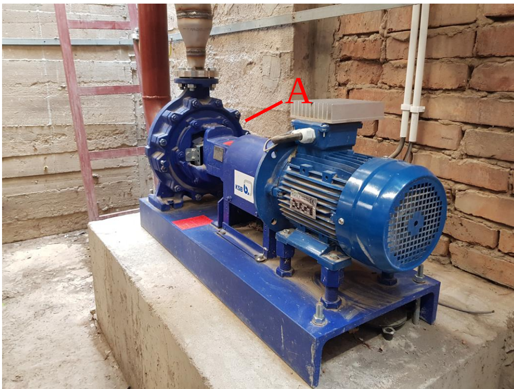
Rys. 5. Komora OFF-Grid po modernizacji: A - zespół turbina - generator
