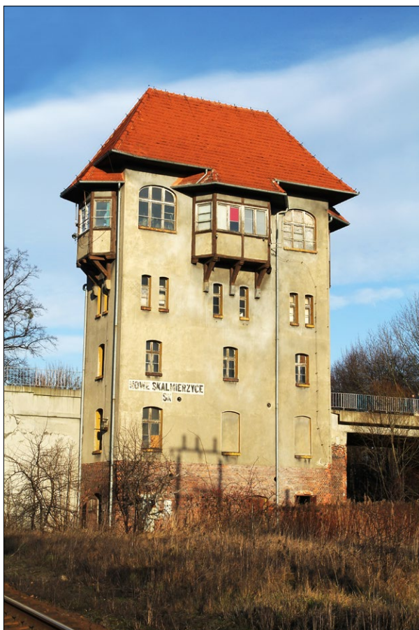
Ryc. 1. Nieczynna nastawnia „wieżowa” w Nowych Skalmierzycach; 2015, fot. M. Urbaniak
