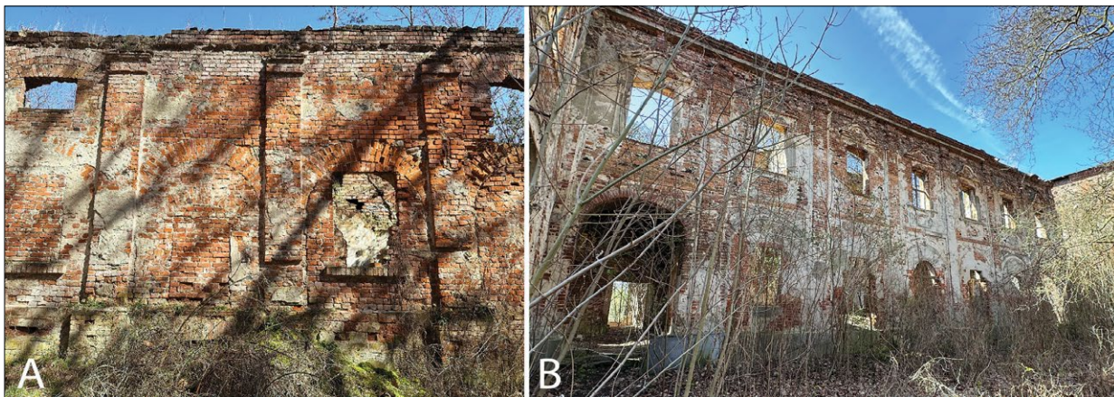
Ryc. 9. Zespół pałacowo-klasztorny: A) fragment elewacji dziedzińcowej z ok. 1681 r. z zablokowanymi arkadami, B) elewacja dziedzińcowa skrzydła zachodniego z ok. 1721 r.; fot. A. Legendziewicz, D. Dobrasiak
