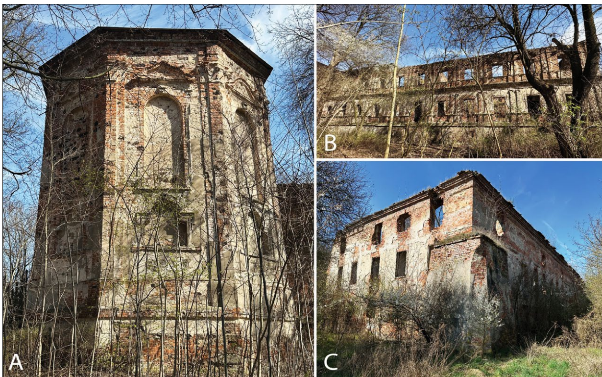
Ryc. 1. Otyń: A) kaplica, B) skrzydło zachodnie, widok od zachodu, C) skrzydło wschodnie, widok od południa; fot. A. Legendziewicz, D. Dobrasiak
