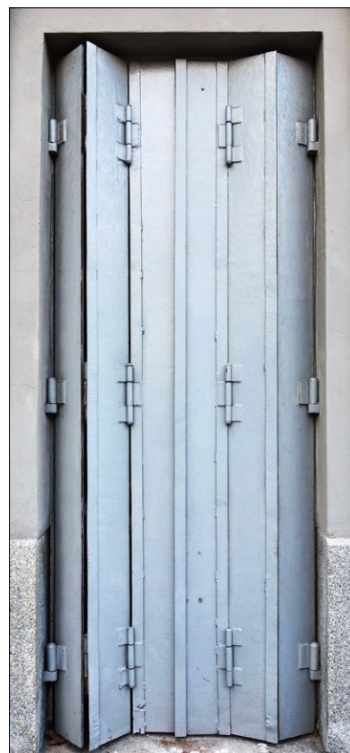
Ryc. 8. Ślusarka drzwiowa nie dekoracyjna w budynku dawnej Dyrekcji Kolei Fig. 8. Non-decorative metalwork door from the former Railway Directorate building
