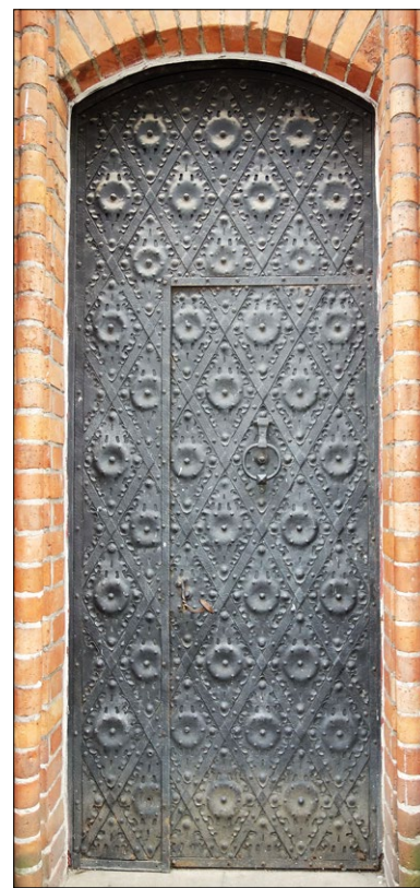
Ryc. 10. Powojenna realizacja ślusarki drzwowej przy ul. Mariackiej 39
