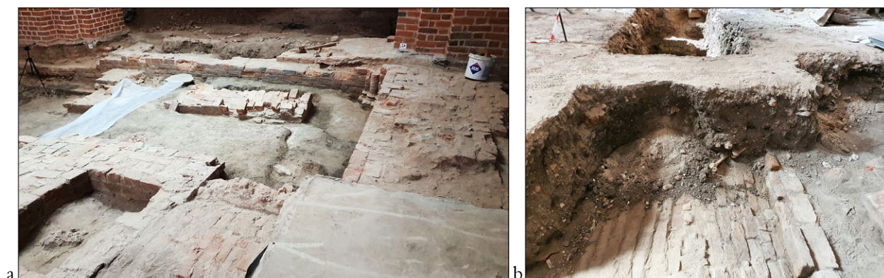
Ryc. 11. Przyszłe warstwy podbudowy posadzki: a) pozostałości wcześniejszej zabudowy, b) sklepienie krypty grobowej; fot. M. Przysiężna-Pizarska, D. Bajno
