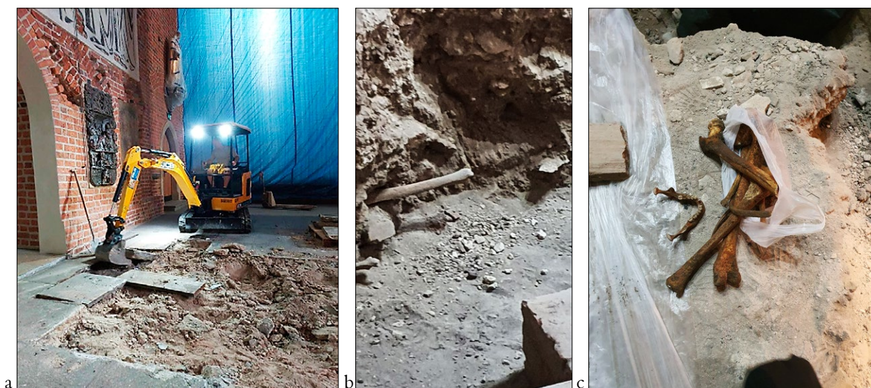
Ryc. 9. Prace budowlano-archeologiczne wewnątrz katedry: a) usuwanie płyt posadzkowych; fot. Sebastian Ruszała, b), c) odsłonięte i wybrane szczątki ludzkie z warstw podbudowy posadzki; fot. M. Przysiężna-Pizarska, D. Bajno
