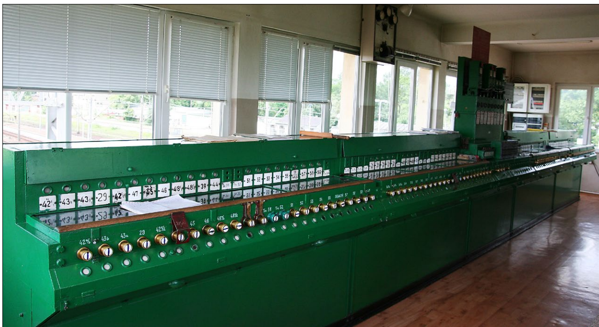
Ryc. 10. Nastawnica elektryczna suwakowa jednorzędowa nastawni „GnA” w Gnieźnie; 2010, fot. M. Urbaniak
