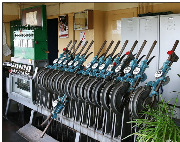
Ryc. 11. Nastawnica mechaniczna z aparatem blokowym w Gnieźnie; 2009, fot. M. Urbaniak
