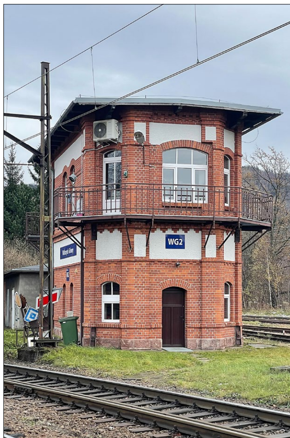
Ryc. 2. Nastawnia wykonawcza „WG2” na stacji Wałbrzych Główny; 2024, fot. M. Urbaniak
