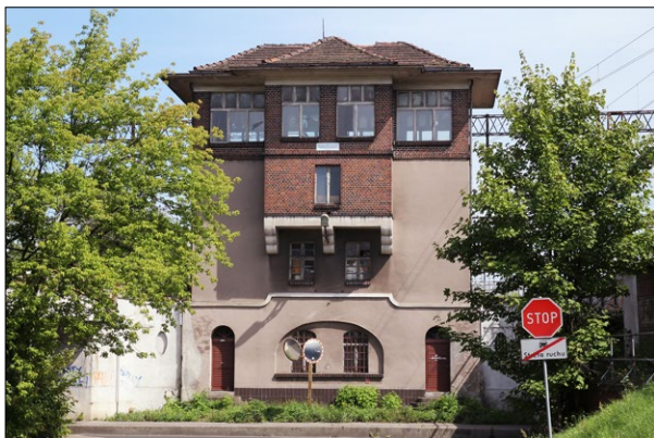
Ryc. 3. Dawna nastawnia wieżowa stacji Toruń Główny; 2018, fot. M. Urbaniak
